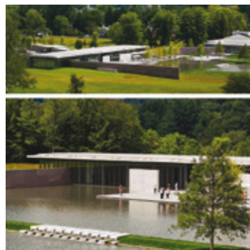
zichtbaar stromend water in meerdere niveaus
