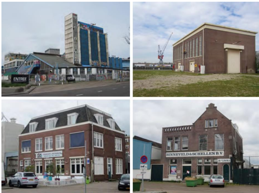
Figuur 3.8: Enkele beeldbepalende objecten, met de klok mee vanaf linksboven: de Emailliefabriek Ferro, het GEB pompgebouw, en de bedrijfspanden aan de Keileweg 14 en 10.
