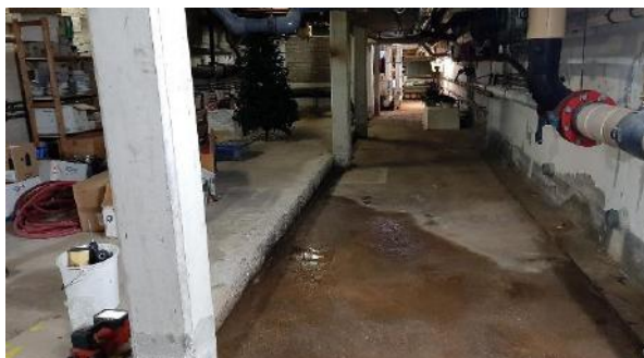
01] Aanzicht van de kolommen in de kelderruimte
