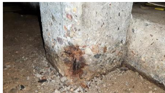
12-13] Aanzicht kolom 3. De schade [holklinkende betondekking] manifesteert zich ook hier met name in de betondekkingszone tot een hoogte van \pm 30 cm boven de vloer. Dieper gelegen beton vertoont een goede samenhang. De hoofdwapening is oppervlakkig gecorrodeerd.
