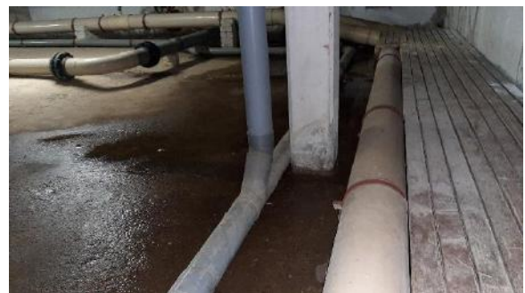
18-19] Kolom 6 en 7 met lichte betonschade / wapeningscorrosie aan onderzijde van de kolom. De omvang van de schade is minder dan de overige kolommen. De waterbelasting is wellicht beduidend minder dan bij de kolommen 1 tot en met 5.
