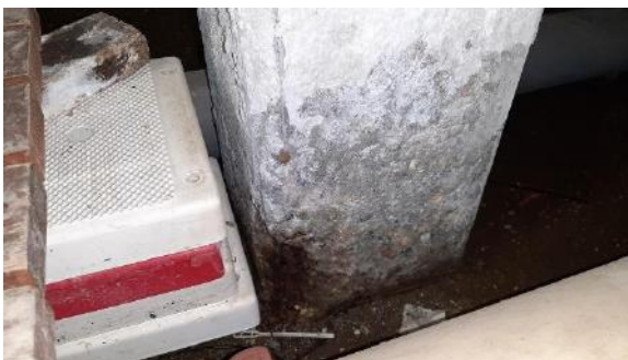
18-19] Kolom 6 en 7 met lichte betonschade / wapeningscorrosie aan onderzijde van de kolom. De omvang van de schade is minder dan de overige kolommen. De waterbelasting is wellicht beduidend minder dan bij de kolommen 1 tot en met 5.
