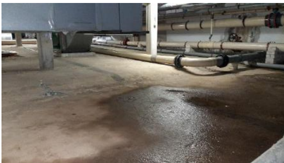
20] Aanzicht overige kolommen. De kolommen staan op een hogere- en droge vloer. Betonschade is niet direct waarneembaar.
