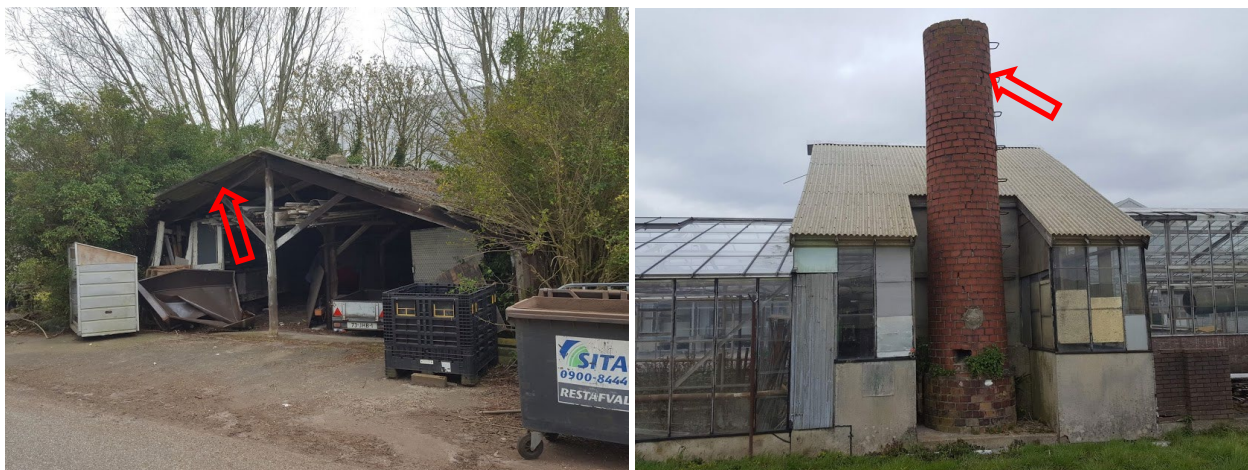
Figuur 8. Door wegkruipruimtes in de constructie van de schuur (foto links, zie rode pijl) en open voegen in de schoorsteen (foto rechts, zie rode pijl) zijn relatief kleine verblijfsmogelijkheden voor vleermuizen aanwezig.
