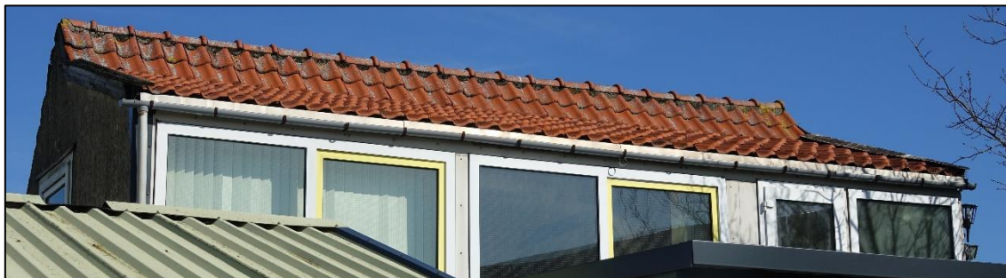
Figuur 9: Het dakpannen zadeldak verkeerd in goede staat. De dakpannen liggen goed recht. Wel is de onderste rij pannen toegankelijk voor soorten als de huismus.
