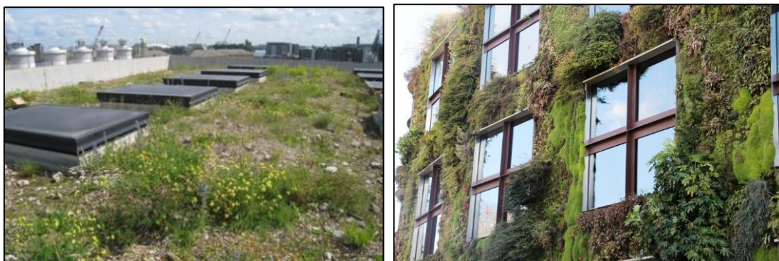
Figuur 14: Bruin dak (links bron: checklist groen bouwen) en groene gevel (rechts bron: groenkennisnet.nl).
