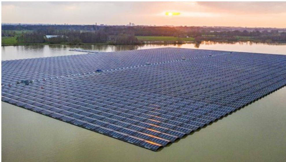
In een plas in de buurt van Zwolle liggen 72 duizend zonnepanelen. Foto: Energiefonds Overijssel
