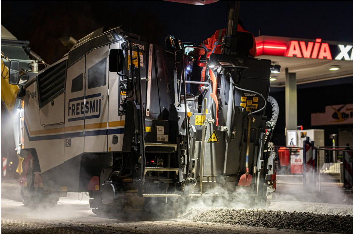
Het frezen van het asfalt in de 1 e fase van de Corridor
