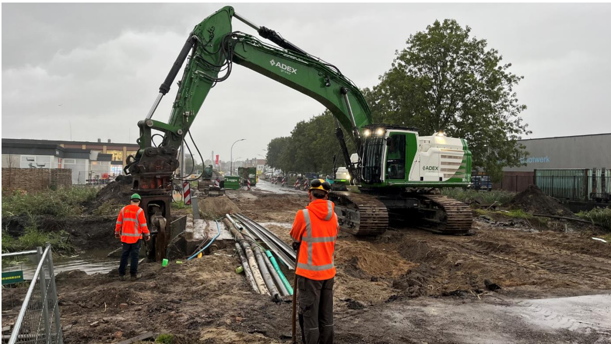
Het slopen van de duiker bij het Noordeinde
