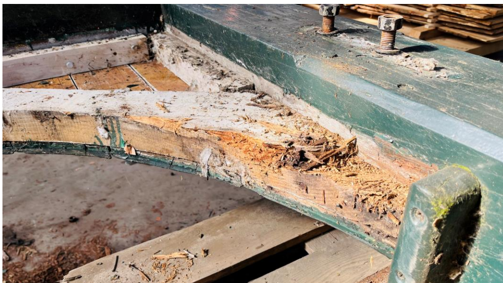
Foto – aangetaste hoekverbinding hameipoort
