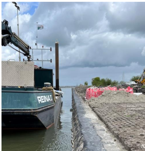
Foto's – uitvoering kade 438 basaltglooiing
