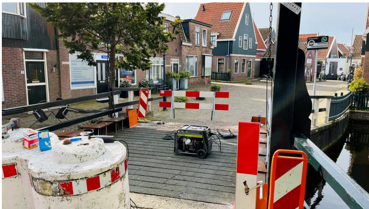
Foto – afsluiting, bouw noodconstructie
