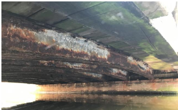
Foto – brugliggers bestaande situatie brug V06
