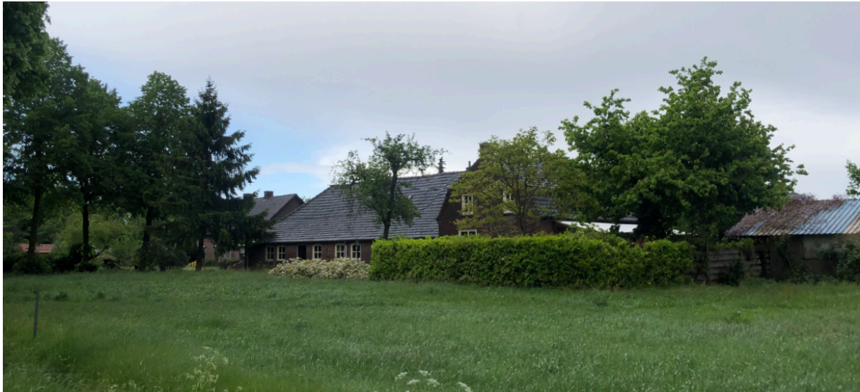
Figuur 6: zicht op de bestaande situatie vanaf de Nieuwstraat gezien
