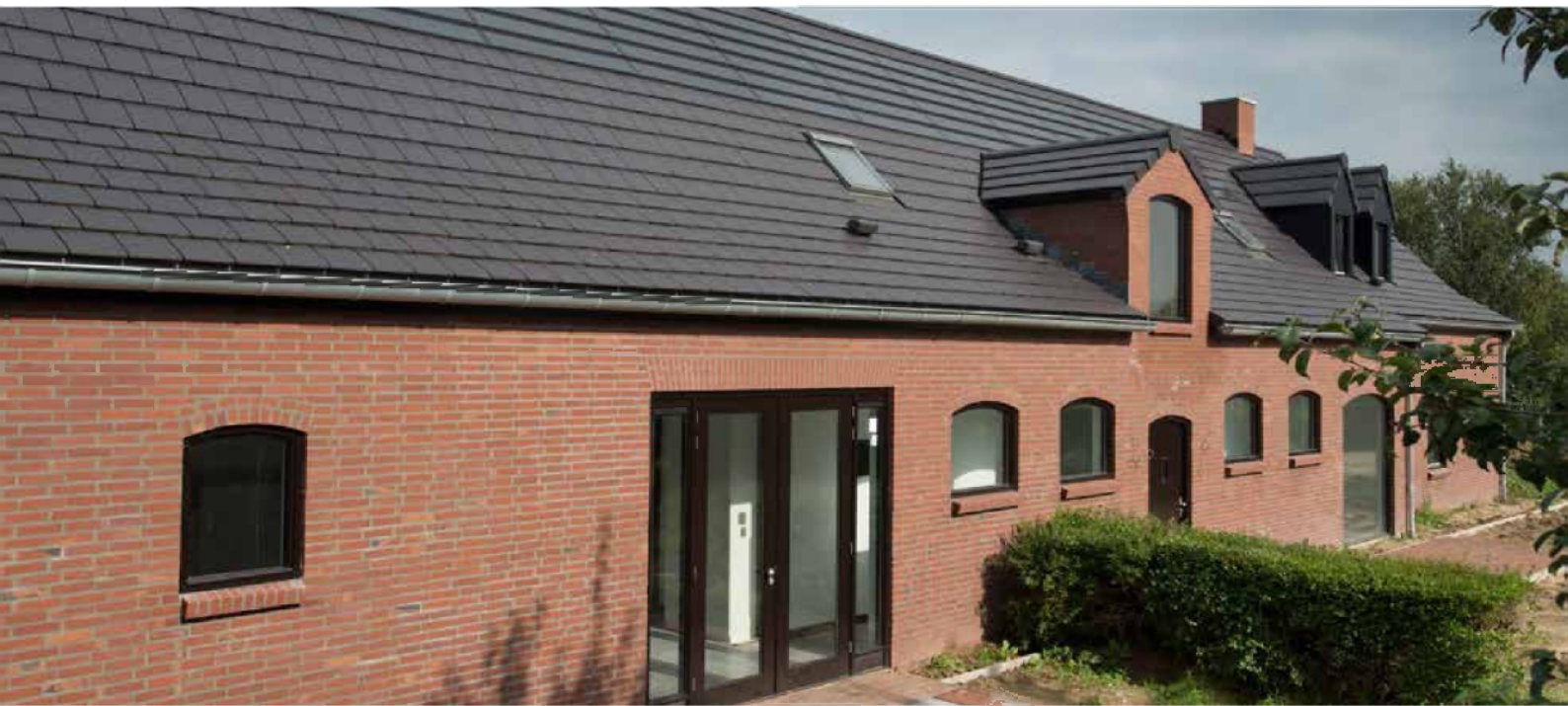
Geïntegreerde zonnepanelen op het dak van seniorenwoningen © BMI Group
