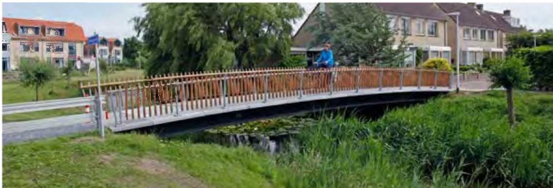
Voorbeeld van een brug met doorlopende oevervegetatie © Wissing
