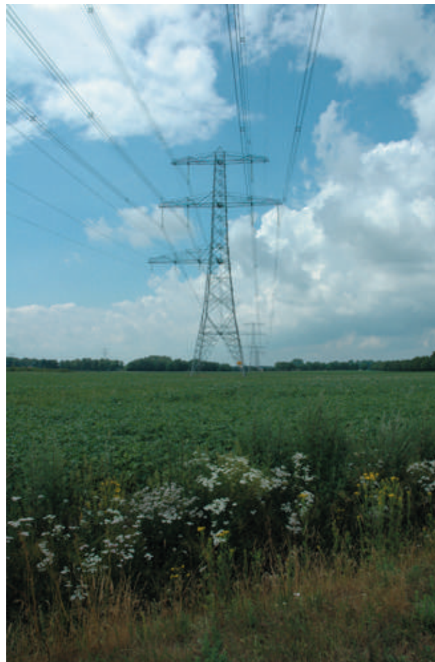
Afb. 68 Hoogteverschil zichtbaar door hoogspanningsleiding
