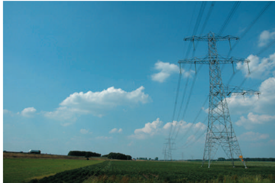
Afb. 5 Nieuwe infrastructuur in beekdal Sleenerstroom
