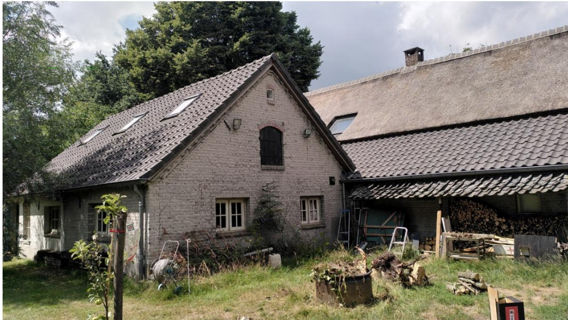
9. Voormalige varkensstal aan de achterzijde van het hoofdvolume.
