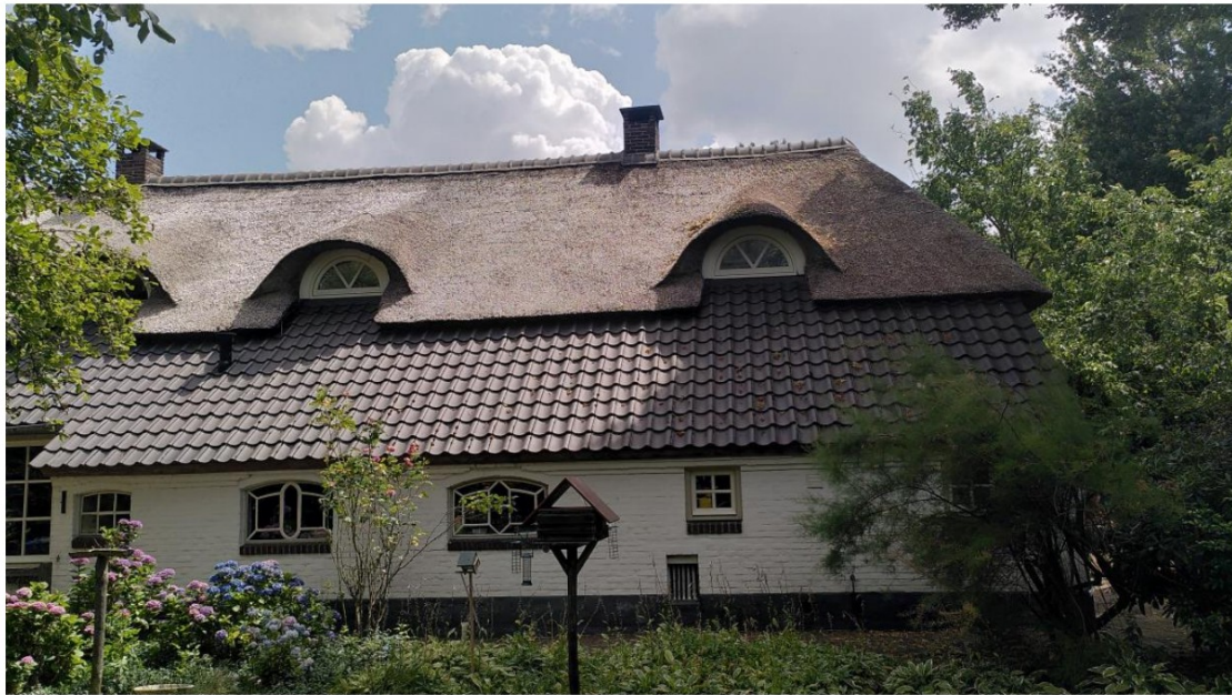
13. Lage gevel woon- en stalgedeelte.
