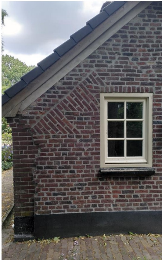
12. Kopgevel woongedeelte met bouwnaden uit de vierde bouwfase.
