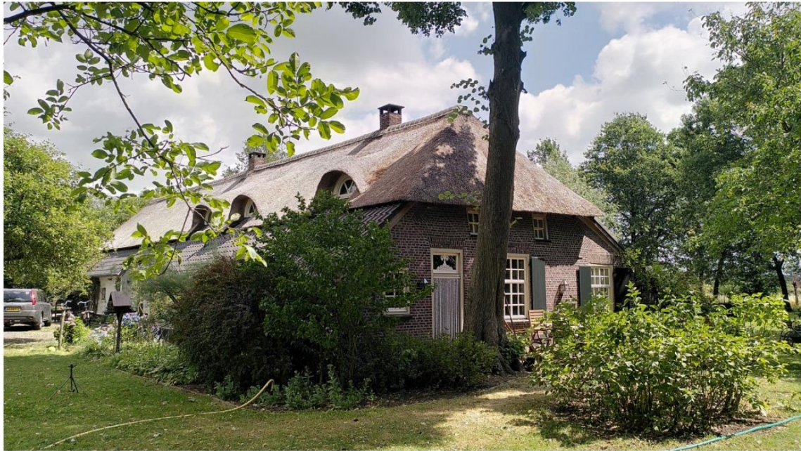
1. Woongedeelte aan de zuidzijde van de boerderij.
