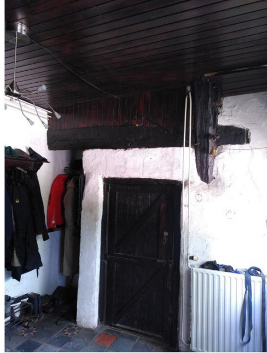
21. Restant van de scheidingsmuur schuur/stal.
