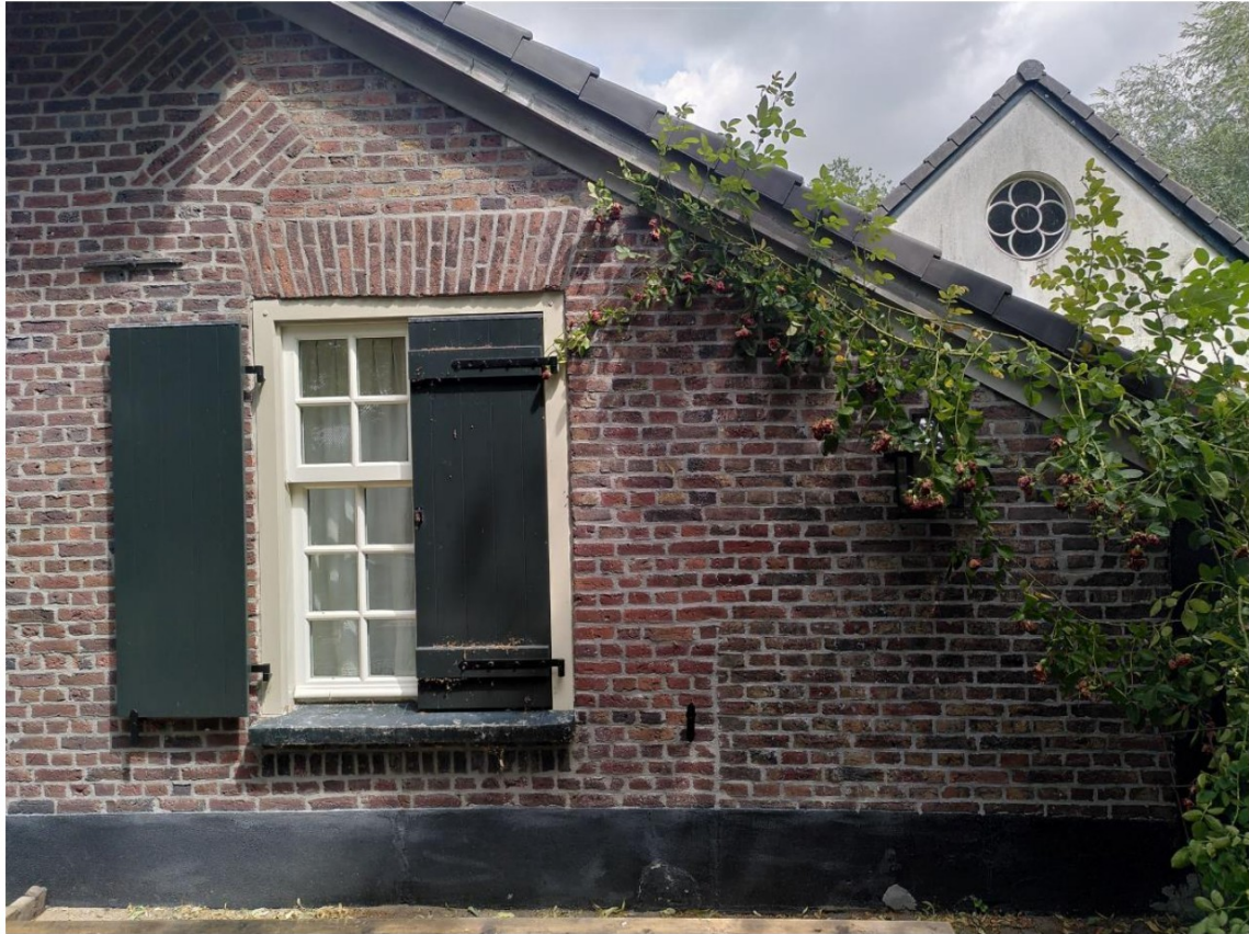
11. Kopgevel woongedeelte met bouwnaden uit de tweede bouwfase.
