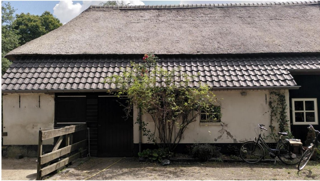
15. Gevel van het schuurgedeelte.
