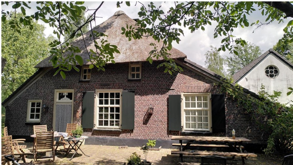
10. Straatgevel van het bedrijfsgedeelte (schuur en stal).
