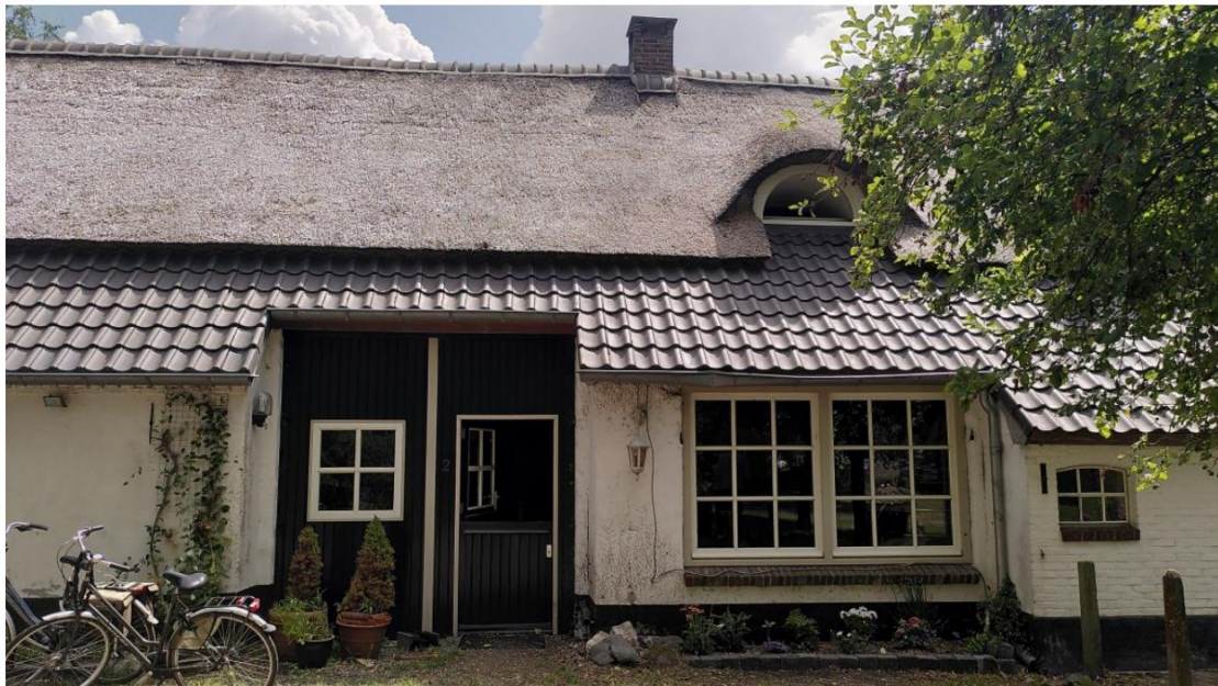
14. Verdiepte gevel met de voormalige staldeur(rechts) en schuurgedeelte (links).
