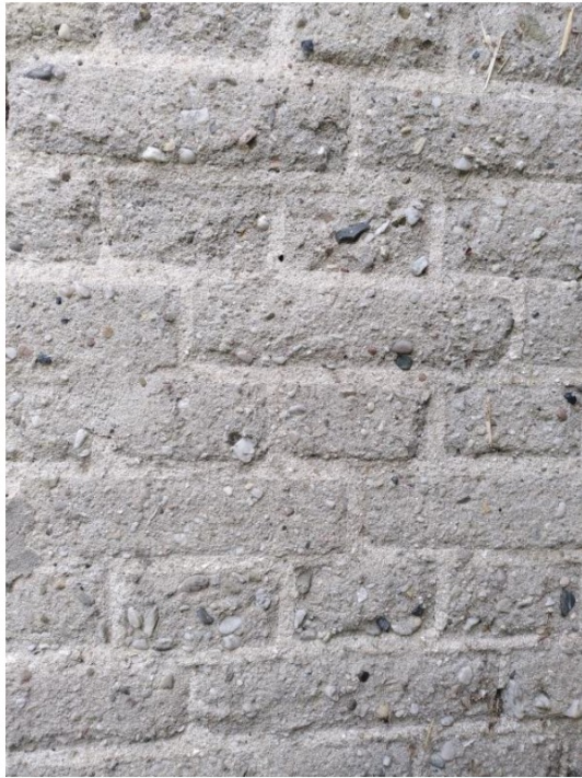
17. Detail cementsteen.
