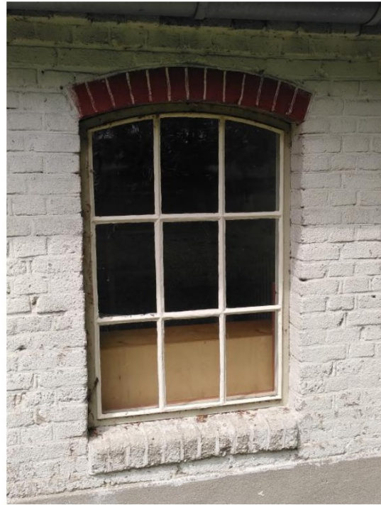
18. Venster in de oostgevel van de varkenstal.
