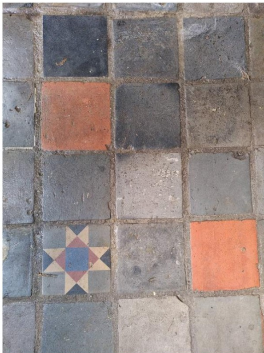
28. Tegelvloer in het halletje schuur.
