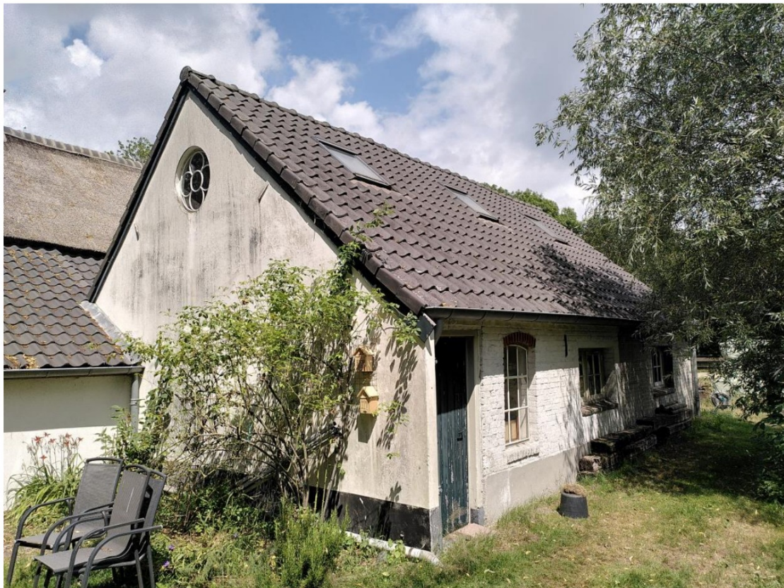
19. Voormalige varkenstal zuidoostzijde.
