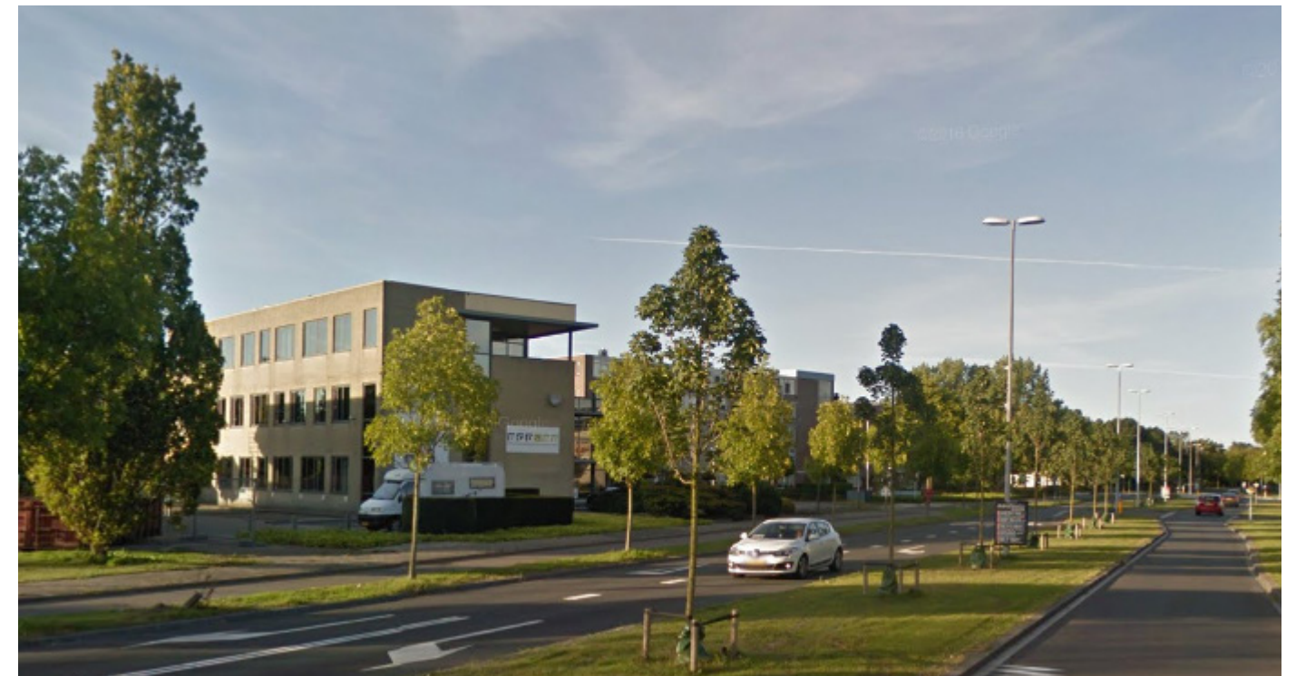
ZICHT OP HUIDIGE PAND VANAF DE ZWAAGMERGOUW
