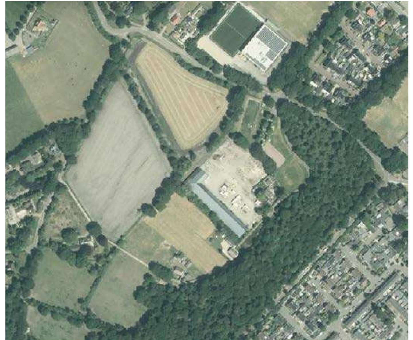
Projectlocatie Hokseberg 't Harde
