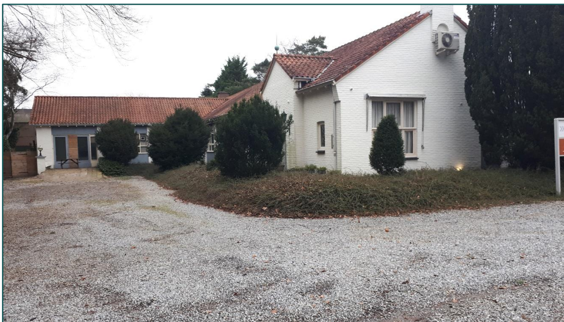
Figuur 1 De planlocatie is gelegen aan de Dennelaan 1/1A te Waalre en bestaat uit een kantoorperceel met twee bedrijven en meerdere groenstructuren. De beoogde ruimtelijke ingreep betreft de sloop van de bebouwing en de kap van enkele bomen ten behoeve van de bouw van twee woningen.
