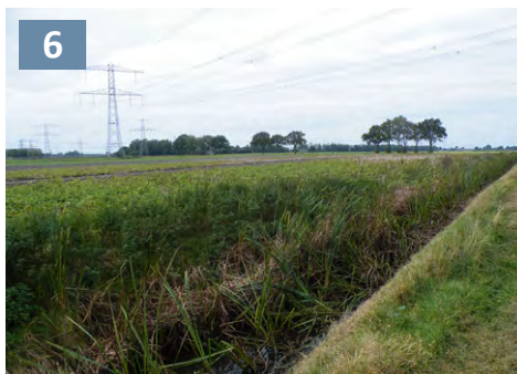
Afbeelding 17. Noordzijde met hoogspanningskabels.
