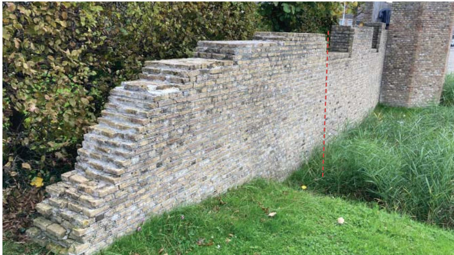
naamstenen: naamstenen hergebruiken in nieuwe of bestaande muur
