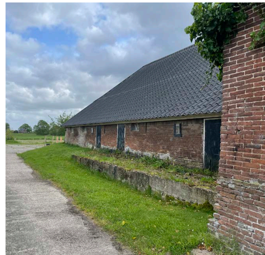
Zicht vanaf achterzijde erf langs schuur/ wagenschuur richting de voorzijde
