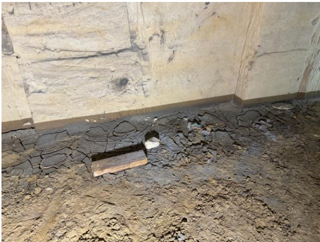
Links: Instroom van aanzienlijke hoeveelheden regenwater tijdens perioden van langdurige regenval. Rechts: Grote verticale scheuren in het mergelpakket boven de groeve zorgen voor actieve instroom van dekgronden en water in het gangenstelsel.
