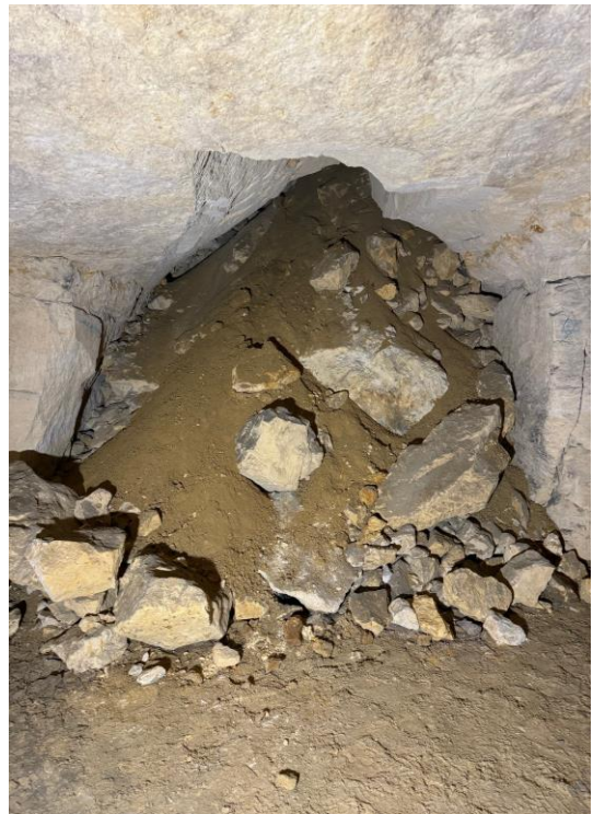
Links: Instroom van aanzienlijke hoeveelheden regenwater tijdens perioden van langdurige regenval. Rechts: Grote verticale scheuren in het mergelpakket boven de groeve zorgen voor actieve instroom van dekgronden en water in het gangenstelsel.
