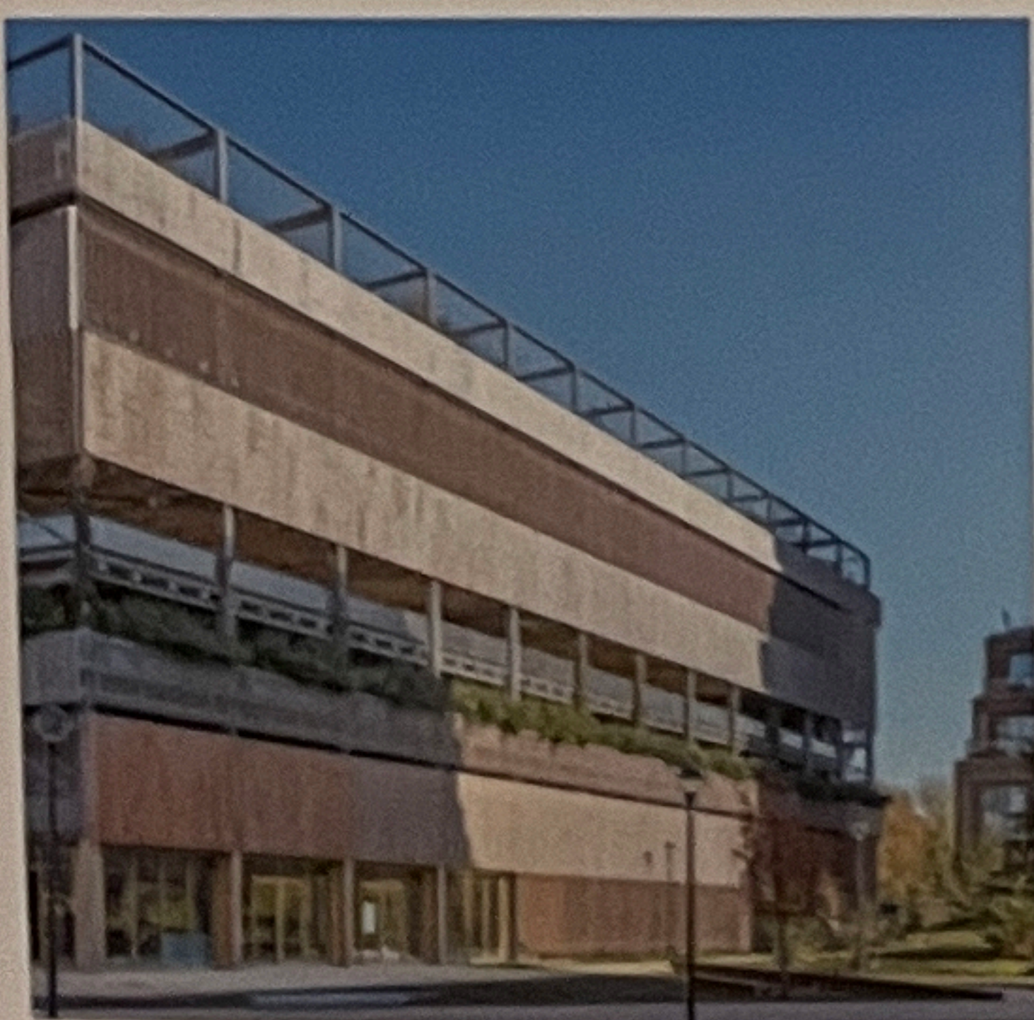
Parkerhub met een houten constructie, groene gevel en een uitzichtpunt op de bovenste verdieping.
