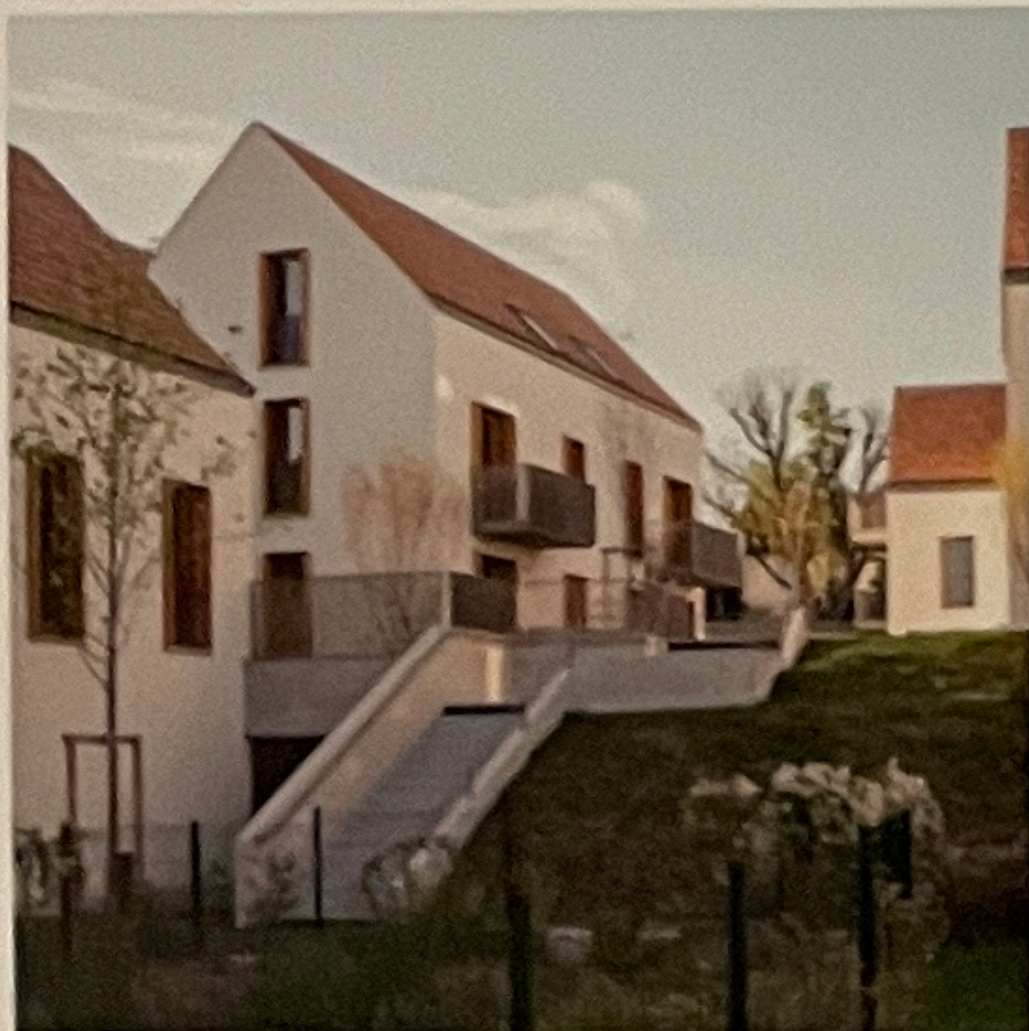
Trappen tussen de woningen die leiden naar het groene dak, waaronder een verborgen parkeergarage ligt.
