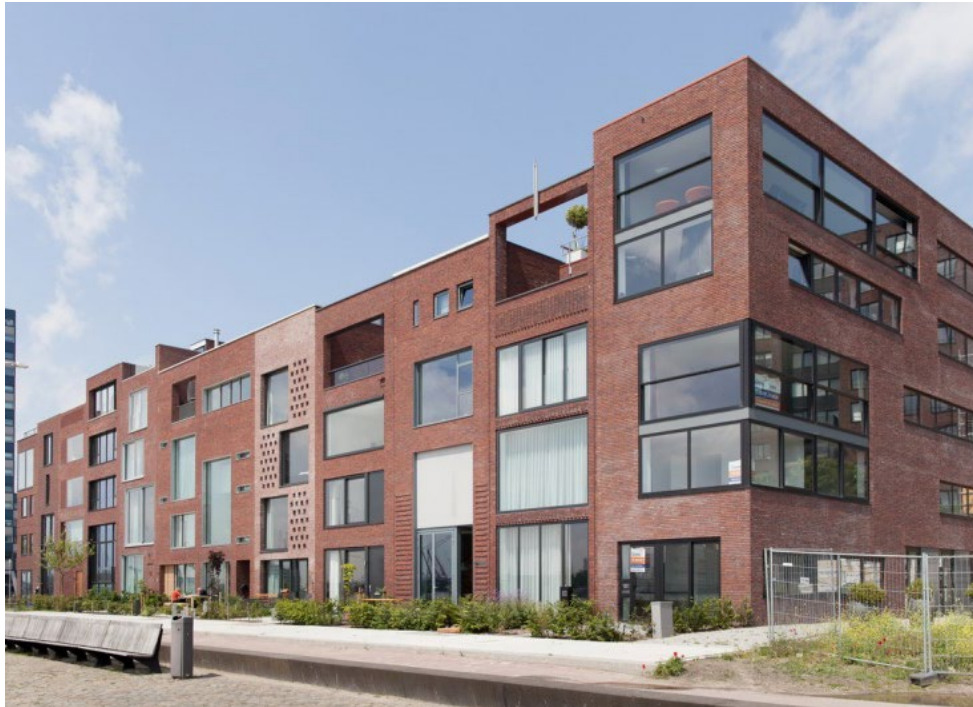
Mullerpier, Rotterdam; Herenhuizen met ieder een eigen uitstraling, maar eenduidig in materiaalgebruik
