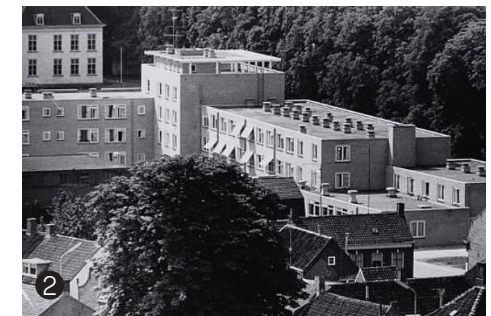
2 Nieuwbouw langs oostelijk deel Slotpark
