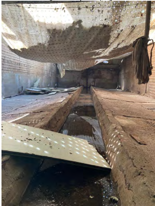
• Afbeelding 21: binnenzijde te slopen gebouw
