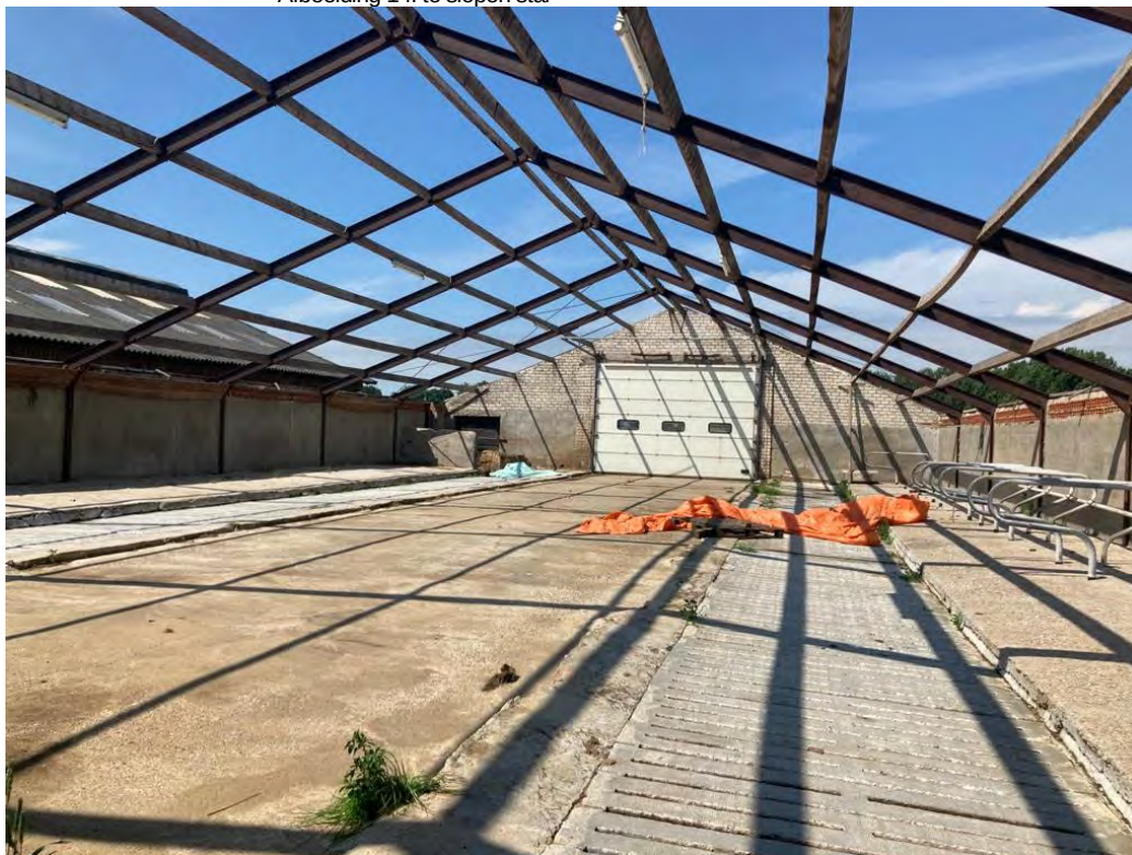
• Afbeelding 14: te slopen stal
