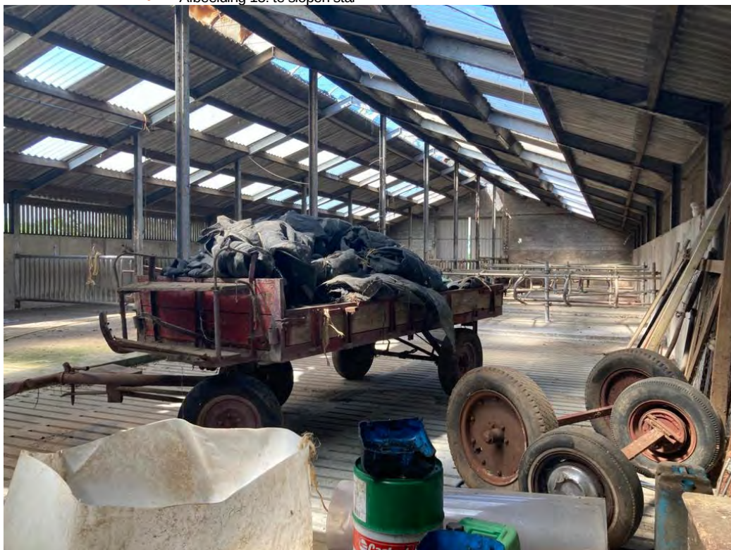
• Afbeelding 15: te slopen stal
