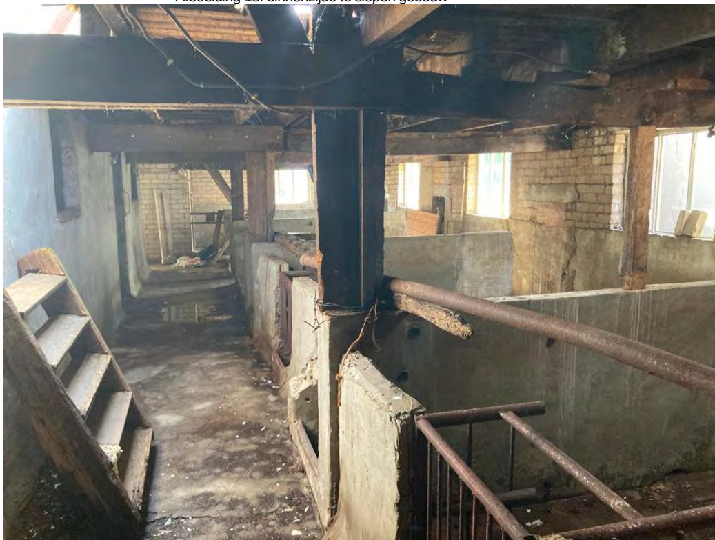
• Afbeelding 18: binnenzijde te slopen gebouw
