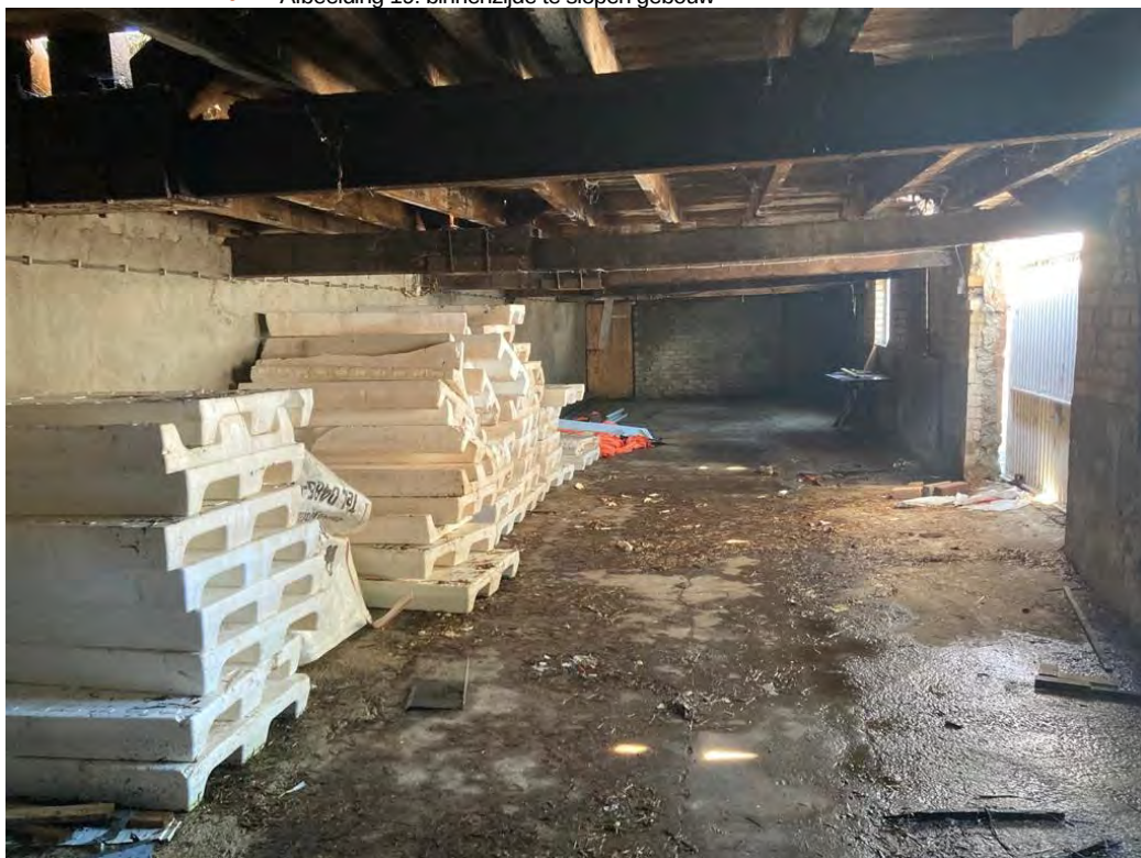
• Afbeelding 19: binnenzijde te slopen gebouw
