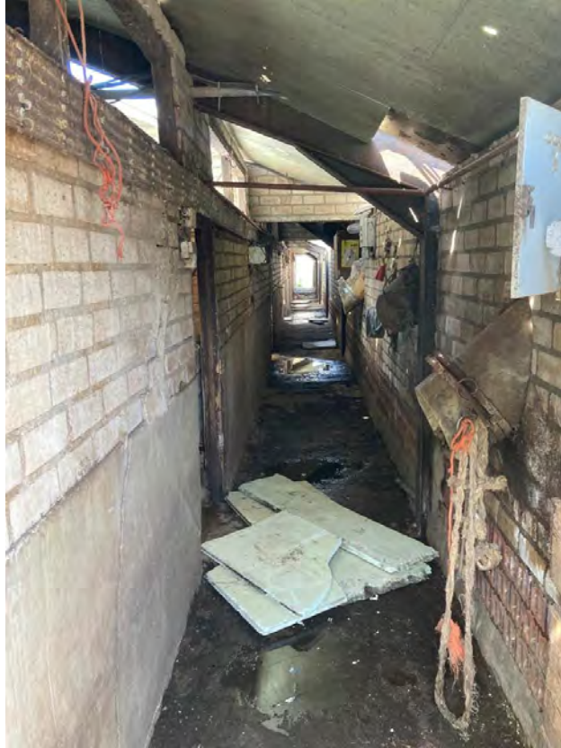
• Afbeelding 20: binnenzijde te slopen gebouw
