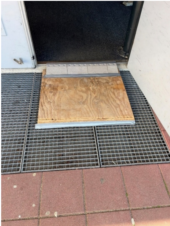
Voorbeeld van een (te smalle) tijdelijke dorpeloverbrugging (links) en een voorbeeld waar de tijdelijke dorpeloverbrugging is verwijderd (rechts)
