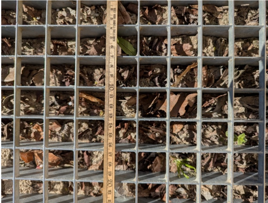
Voorbeeld van een schoonlooprooster met een maaswijdte van 3x3 cm
