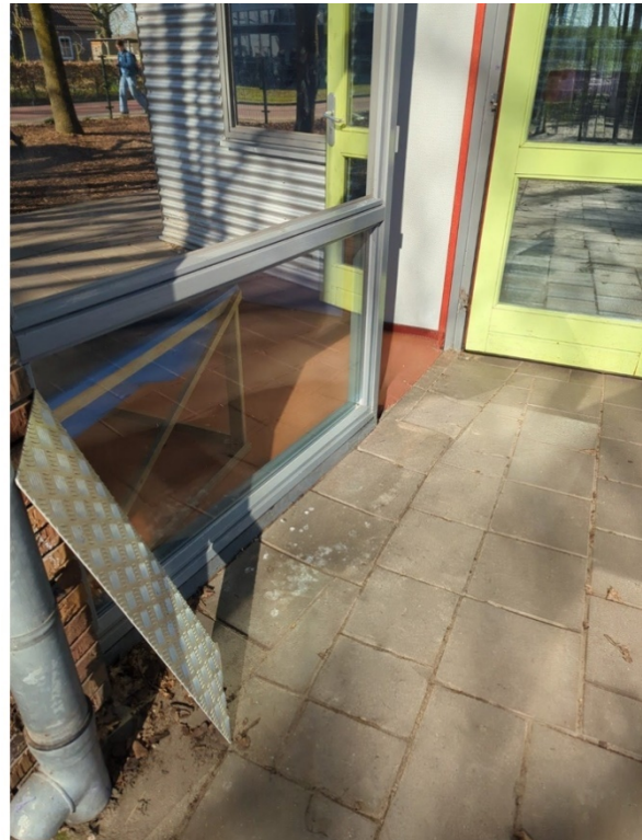
Voorbeeld van een (te smalle) tijdelijke dorpeloverbrugging (links) en een voorbeeld waar de tijdelijke dorpeloverbrugging is verwijderd (rechts)
