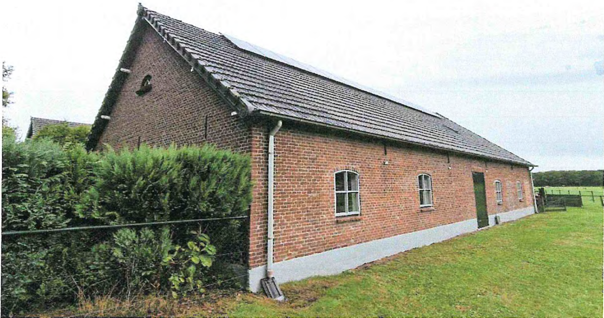
Figuur 2: Foto bestaande schuur wordt woning
