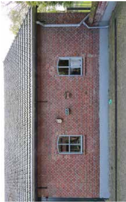
linker zijgevel stal met later aangebrachte betonnen vensters
