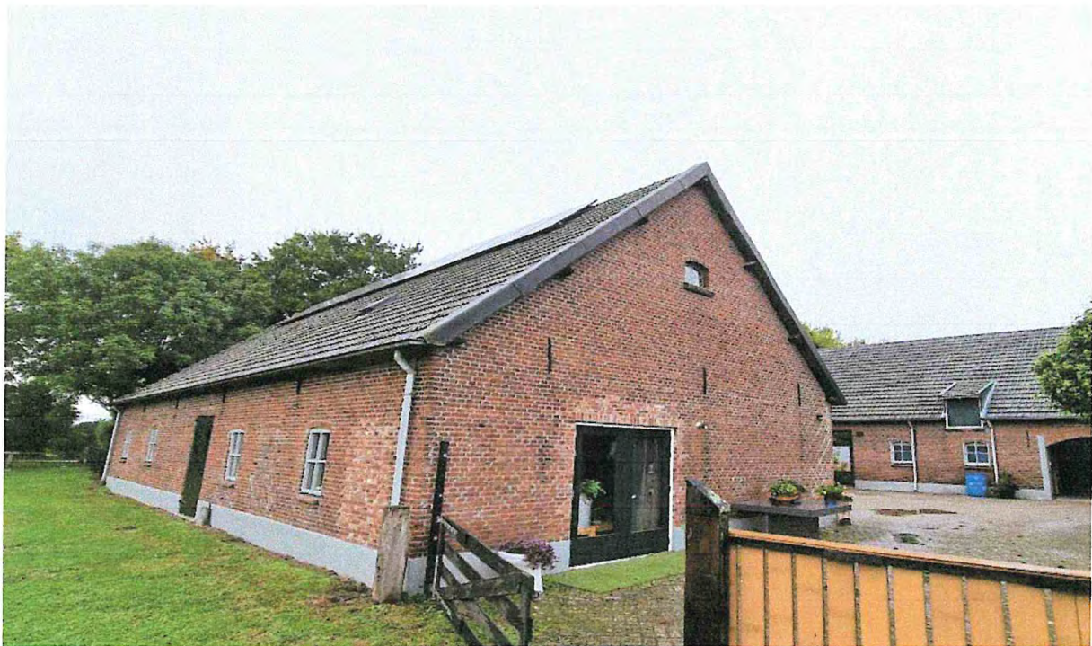
Figuur 3: Foto bestaande schuur wordt woning
