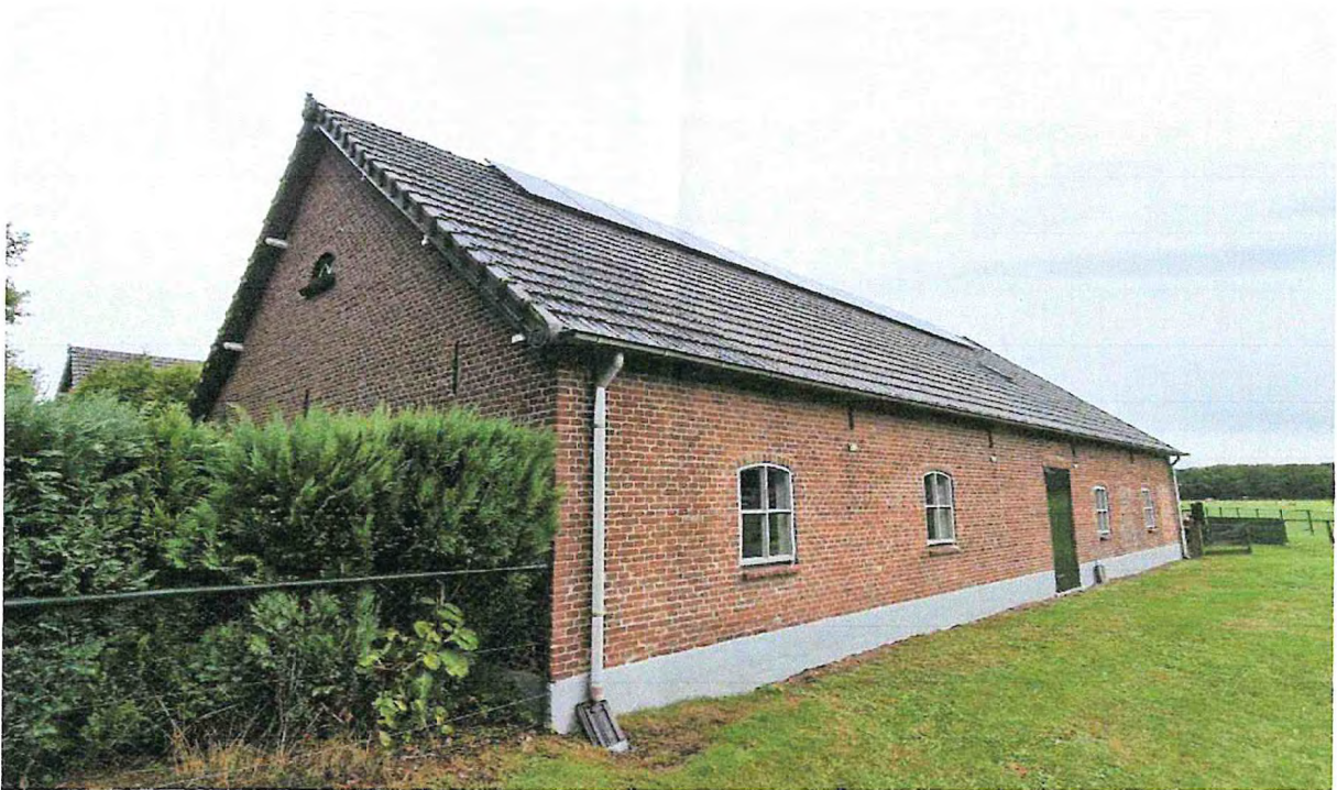
Figuur 2: Foto bestaande schuur wordt woning
