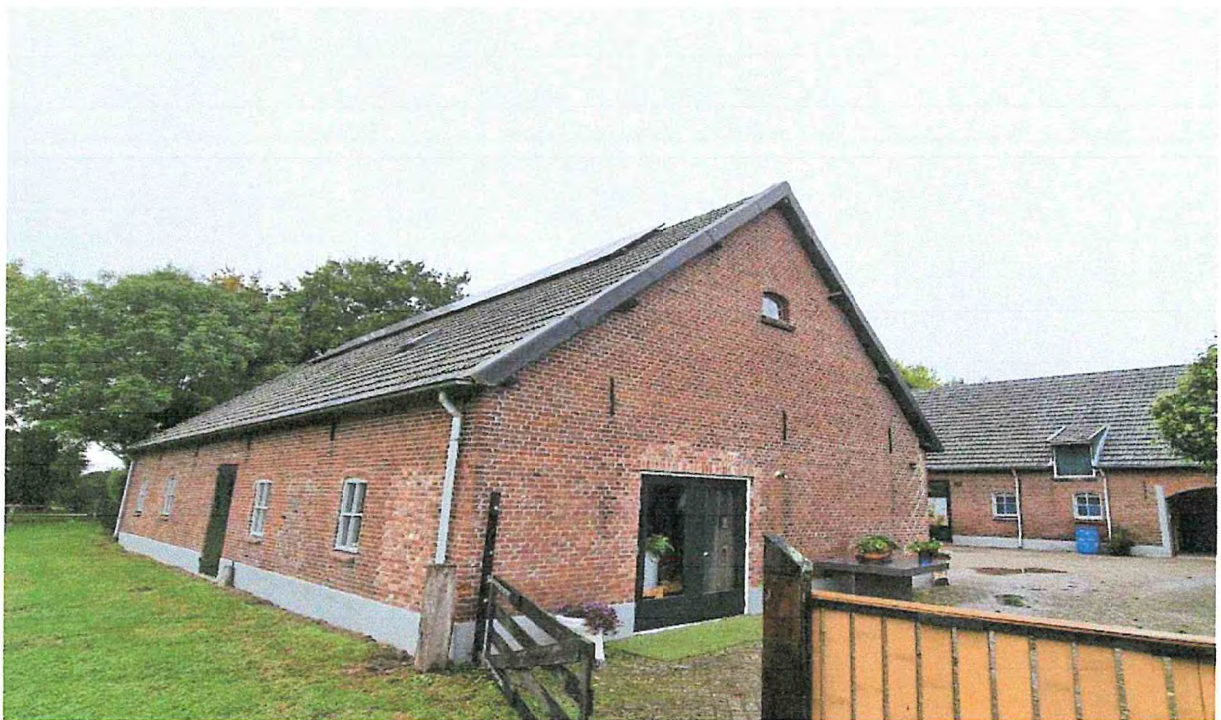
Figuur 3: Foto bestaande schuur wordt woning
