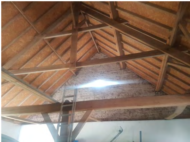
Figuur 11. Dakbeschot binnenkant stal.
