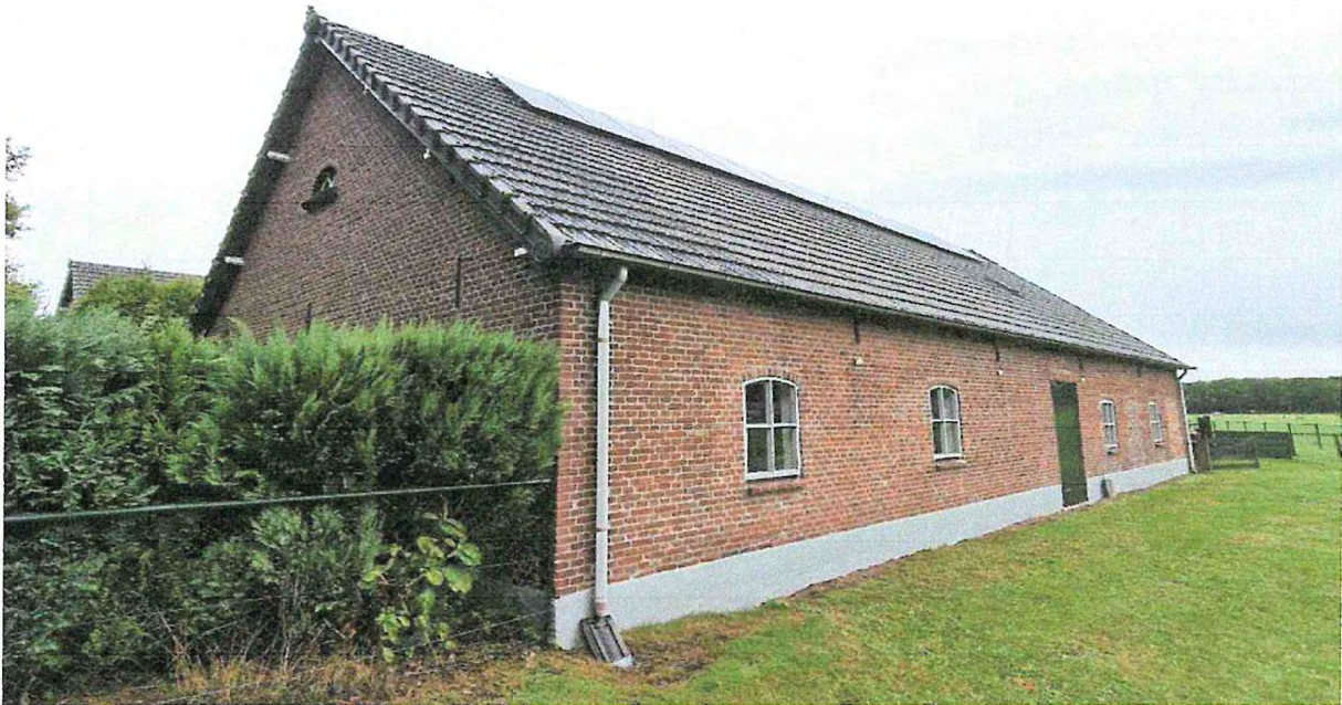
Figuur 2: Foto bestaande schuur wordt woning
