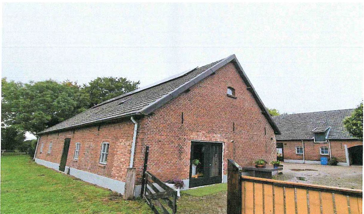
Figuur 3: Foto bestaande schuur wordt woning
