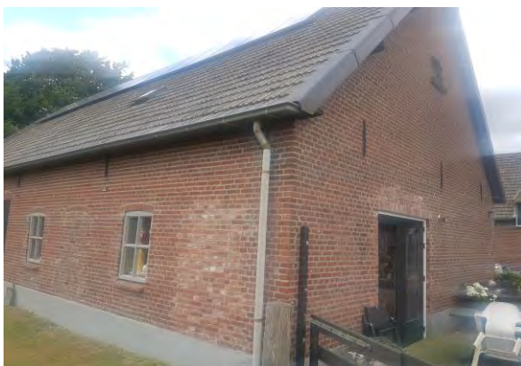
Figuur 4. Aanzicht achtergevel.
