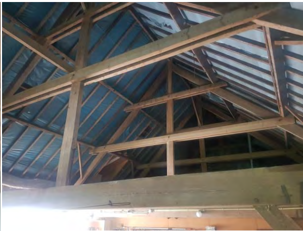
Figuur 12. Dakbeschot binnenkant garage (aan woonhuis).
