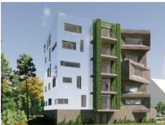
Noordgevel woontoren Waderlo
