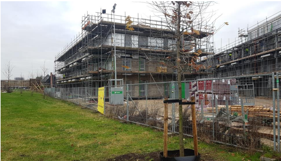
Figuur 1.6 Bouwplaats boven het Klaas van Beeckpad.
