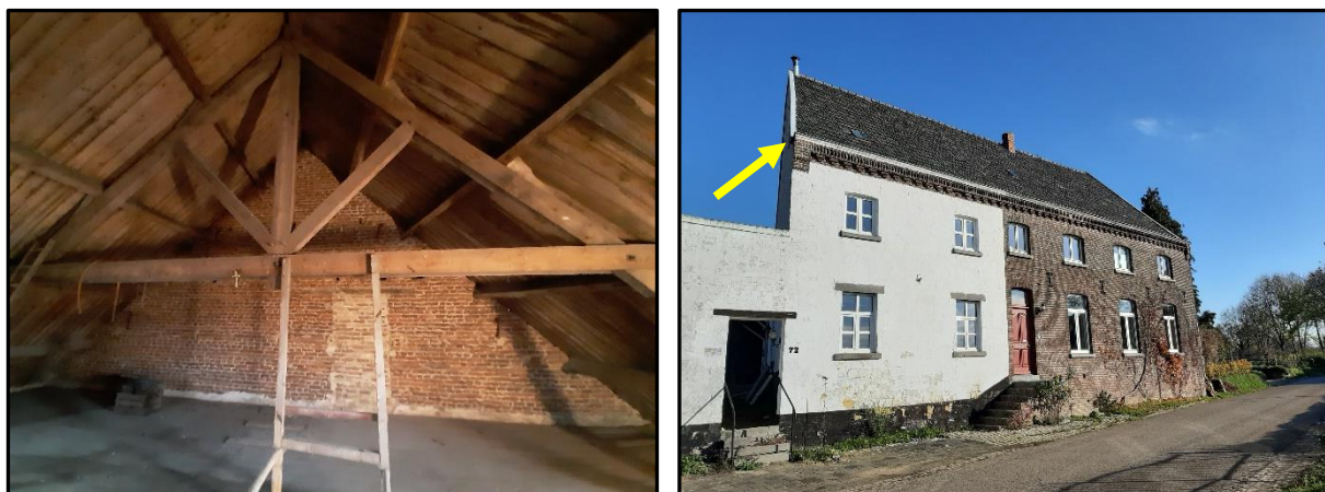
Figuur 3.3 rechts de situatie bovenzijde dak en links zichtbaar het houten dakbeschot; deze combinatie maakt het pand geschikt als verblijfplaats voor vleermuizen.
