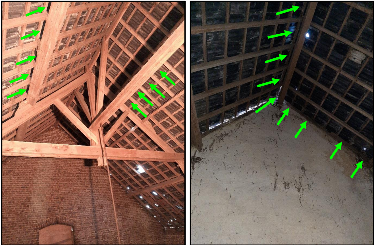
Figuur 3.2 locaties geschikt voor vleermuizen (groene pijl), namelijk de sporen en dakbalken waaraan ze kunnen hangen c.q. zich kunnen verbergen.
