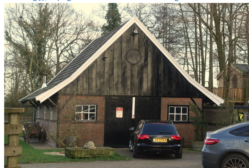
Rosinkweg 35, de vakwerkschuur vanaf de straat gezien. FH MAB 2020
