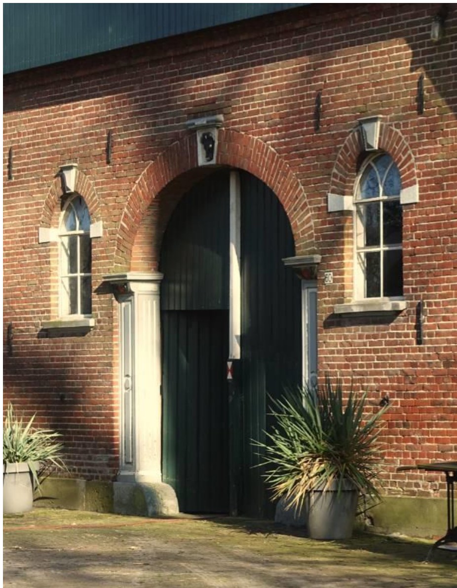
Harberinksweg 60: Achtergevel met de fraai gedetailleerde deeldeuren doorgang met klassiek gedetailleerde pilasters. In de sluitsteen een koeienkop. FH MAB 2020
