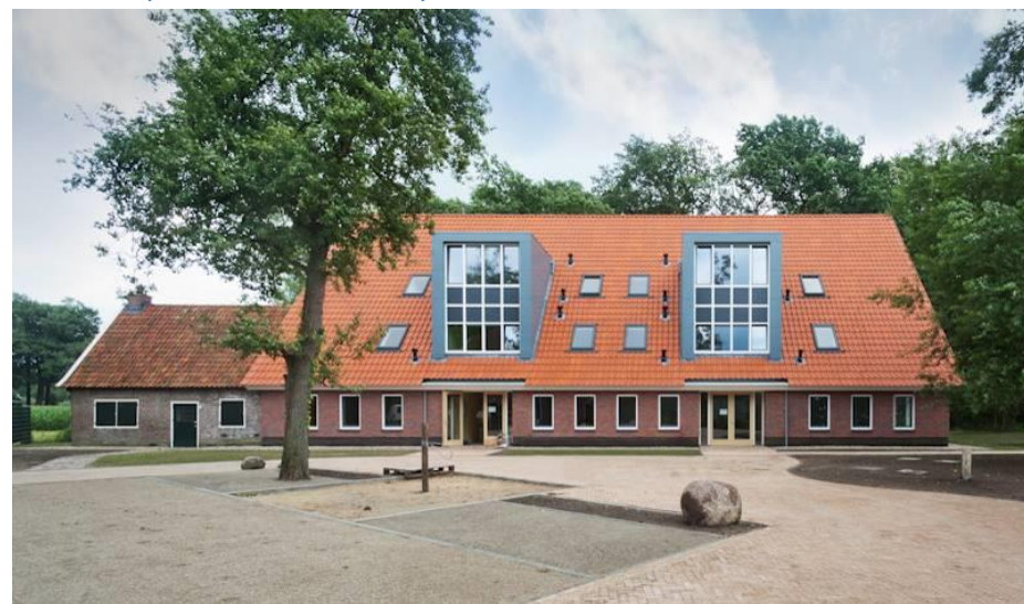
De nieuwe grote zorgboerderij met links de oude bovenkamer kort na de voltooiing. https://www.haafkes.nl/project/restauratie-zorgboerderij-het-eulderink-enschede/
