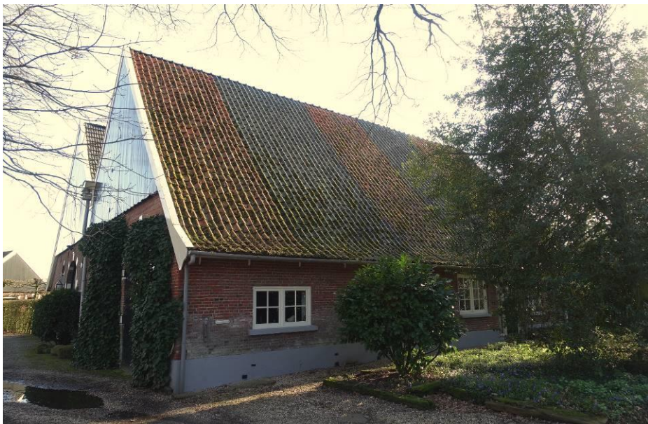
Achtergevel en zijgevel van de boerderij. FH MAB 2020.
