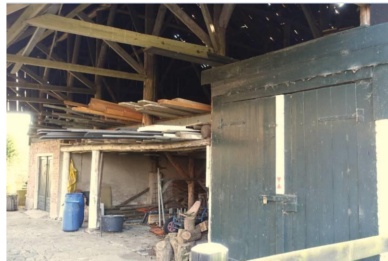
Zicht op de constructie van de wagenschuur. FH MAB 2020.
