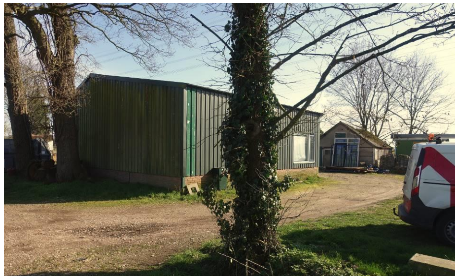
Harberinksweg 15. De jonge schuur (noord- en westzijde) vanaf de straat gezien. FH MAB 2020
