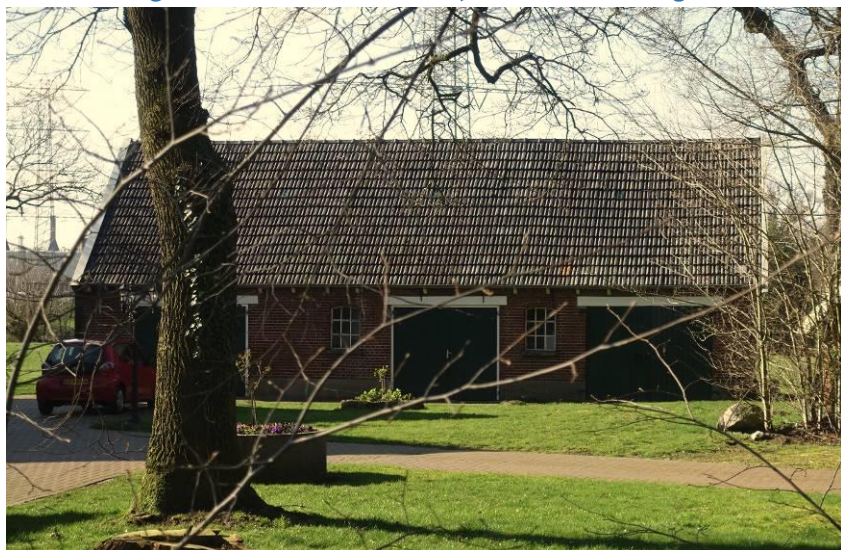
Harberinksweg 2 varkensschuur, oostgevel. FH MAB 2020
