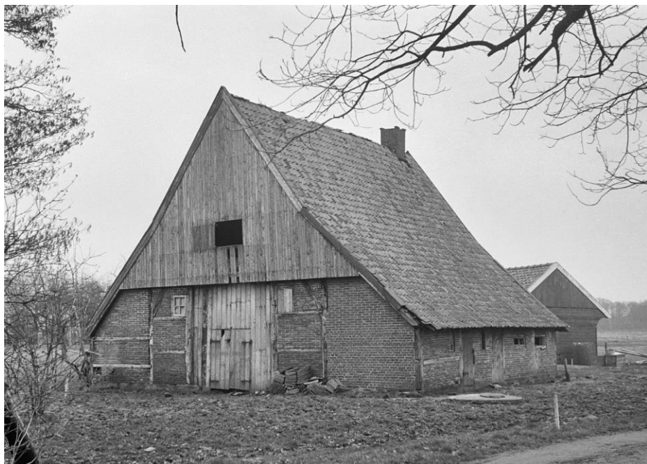
Schuur met restanten vakwerk in de gevels. Helmerstraat 420 Enschede. Foto P.C. Schellekens 1967 Beeldbank RCE 115.140a
