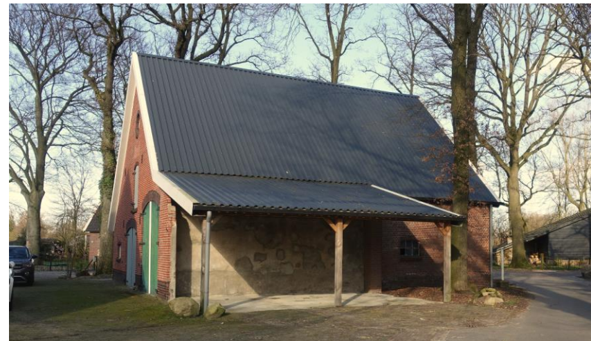
Harberinksweg 49. Zijgevel schuur vanaf de Keuperweg gezien. FH MAB 2020.
