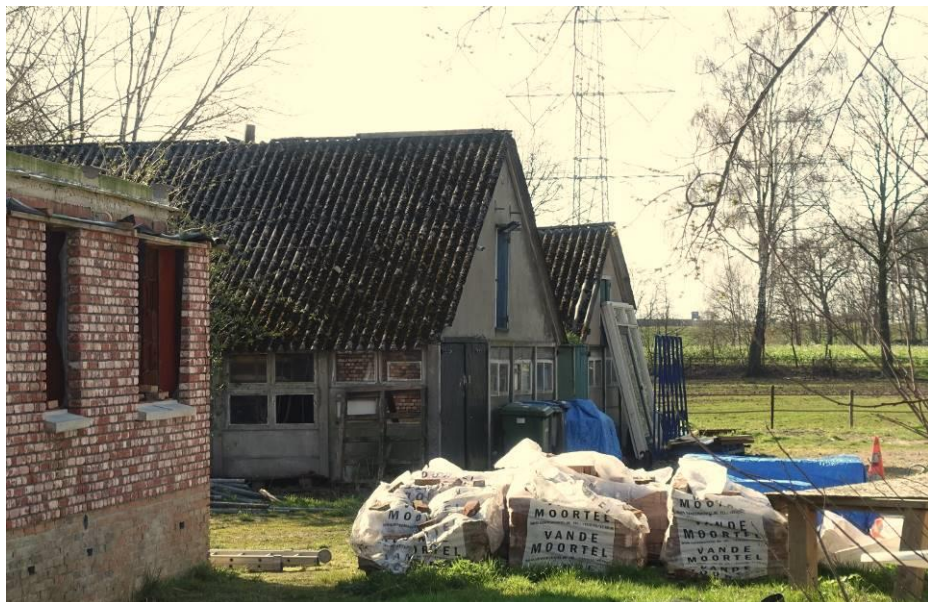
Harberinksweg 15. De dubbele prefab-betonnen schuur en links het nieuwe huis in aanbouw. FH MAB 2020
