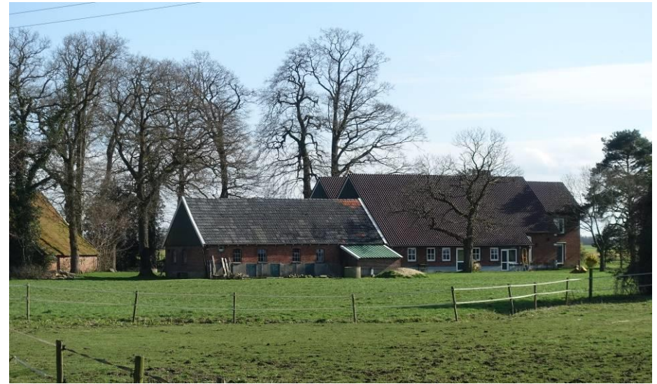
Harberinksweg 2 vanuit het noorden gezien. FH MAB 2020
