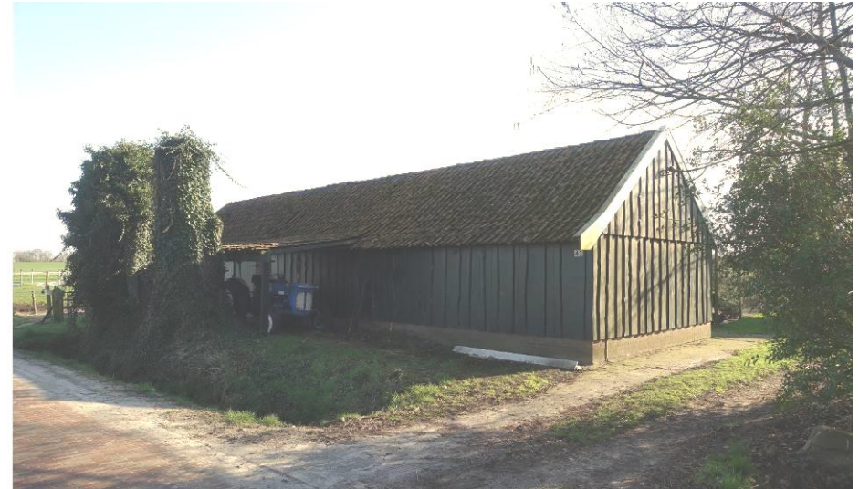
De paardenstalling Harberinksweg 43 heeft in de westelijke helft houten wanden op een gemetselde plint en aan de oostzijde bakstenen gevels met een houten geveltop (onder). FH MAB 2020.
