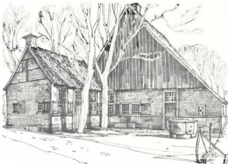
174 De Hof te USSILO (gem. Enschede) De boerderij met aangebouwde „boavenkamer“, werd in 1801 opgetrokken. Put en plin van Bentheimersteen. De ramen bezaten houten roeden (verbouwd).
