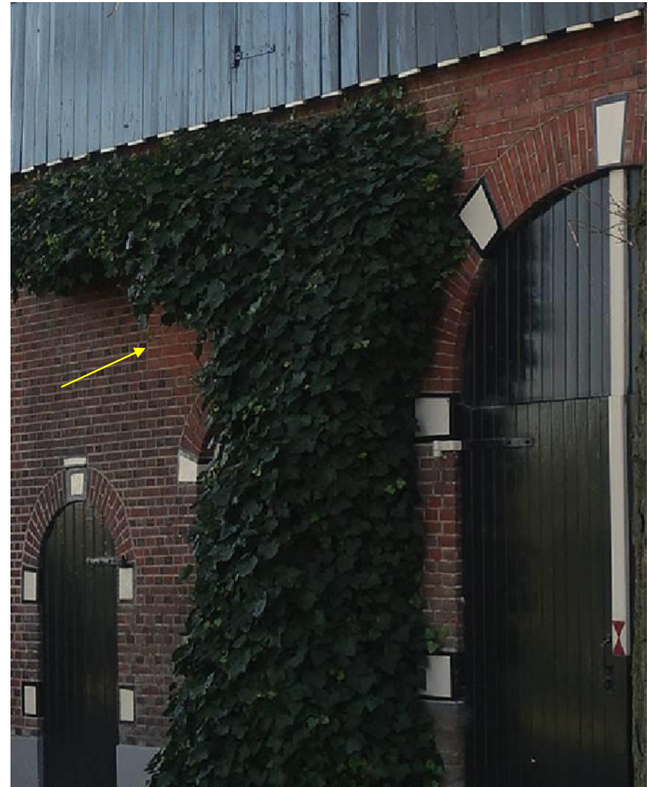
Bouwnaad (gele pijl) in de achtergevel van de boerderij. FH MAB 2020
