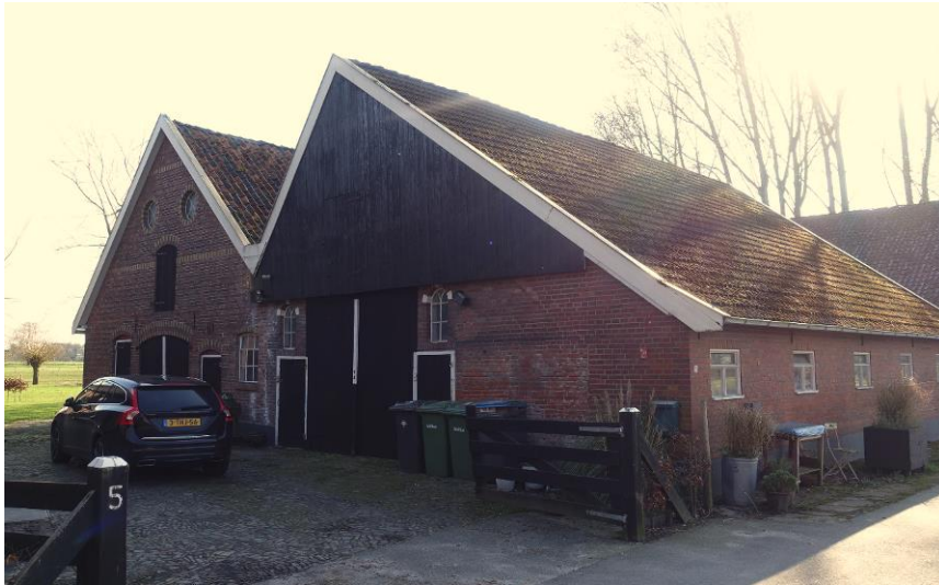
De tweekapschuur bevat rechts de kern van de kort voor 1904 vernieuwde schuur en links de in 1921 tot stand gekomen uitbreiding. De gevel rechts aan de straat is later (jaren 60?) gemoderniseerd. Het erf heeft nog een oude keitjesbestrating. FH MAB 2020
