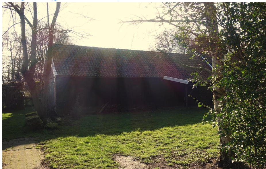
De ingekorte schuur gezien vanaf de Harberinksweg. FH MAB 2020
