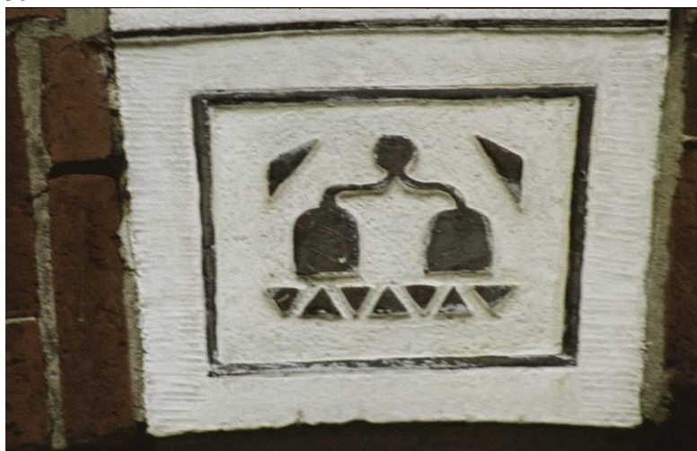
Geerdinkweg 20. Sluitsteen met huwelijkssymbool in de boog van de deeldeuren. Beeldbank RCE Coll Ferro 548-14
