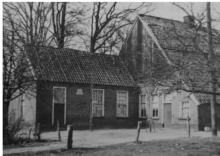
Boerderij met bovenkamer met eigen entree in Geesteren. Twentse-erven.nl
