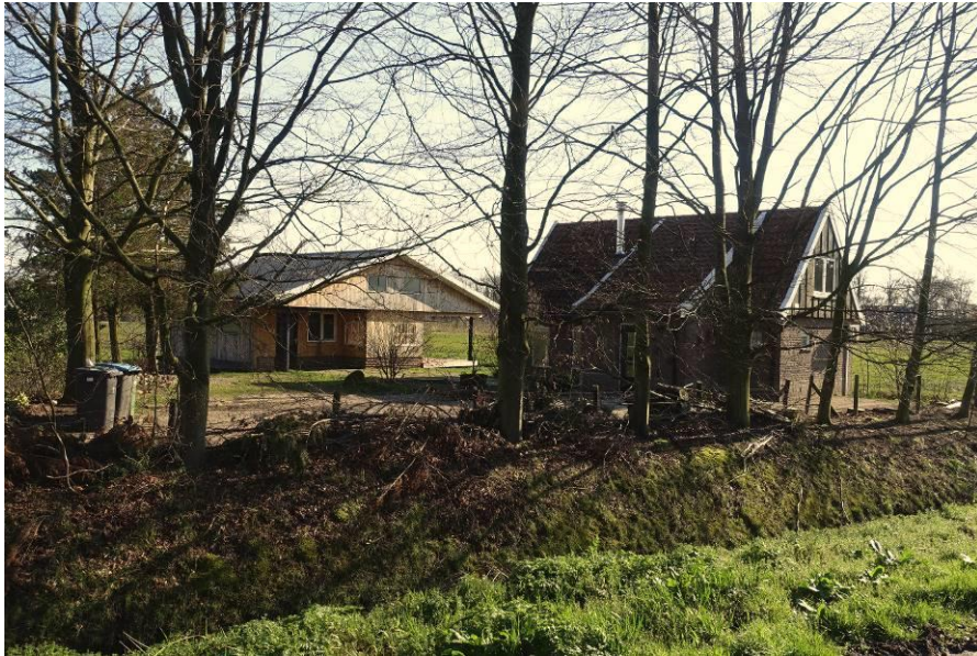
Harberinksweg 59 vanuit het noorden gezien. FH MAB 2020
