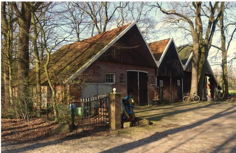
De tussen 1910 en 1916 in deze vorm ontstane driekapschuur. FH MAB 2020
