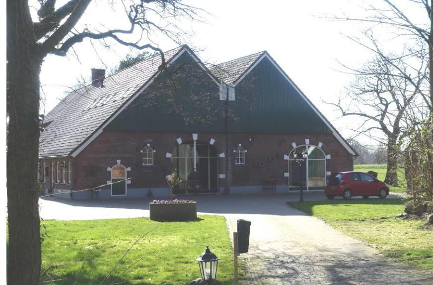
Harberinksweg 2, boerderij met dubbele kap, noordgevel. FH MAB 2020
