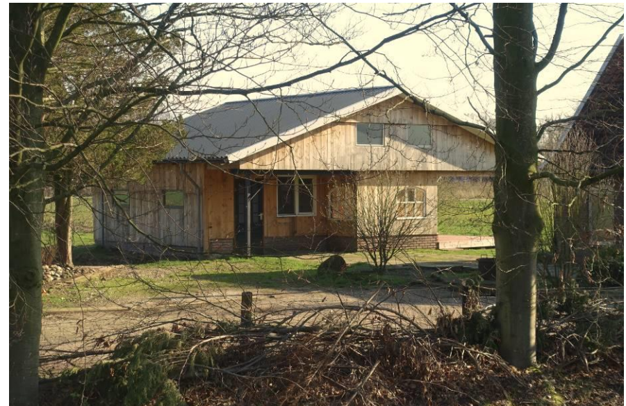
Harberinksweg 59, schuur vanuit het noorden gezien. FH MAB 2020
