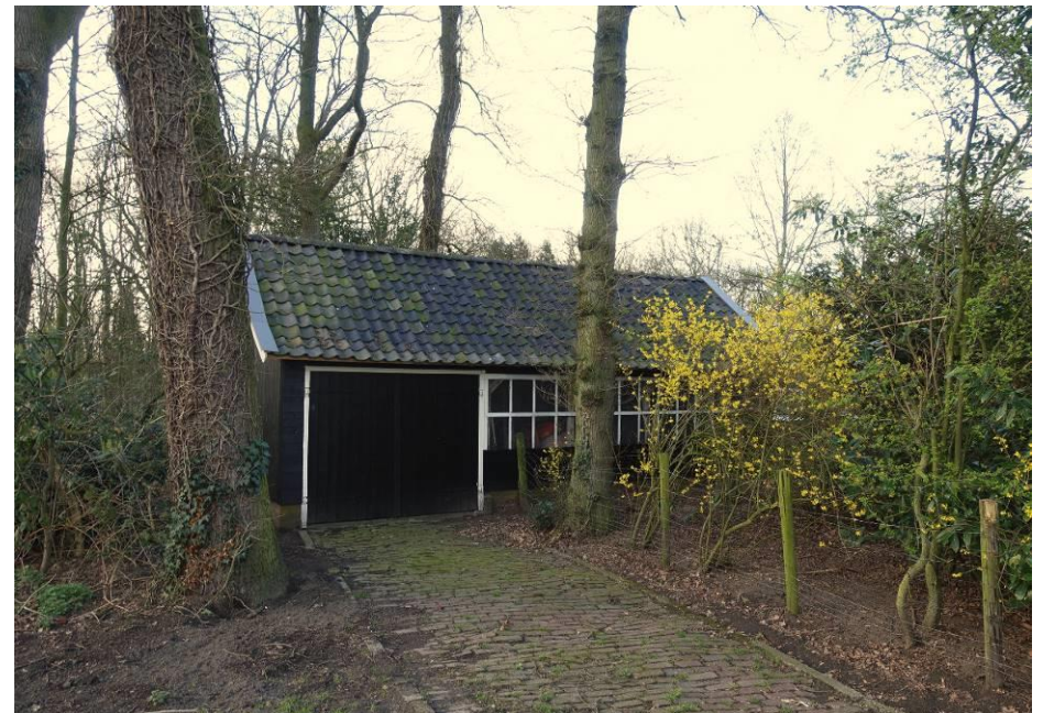
De kleine kippen(?)schuur met oprit vanaf de straat, gezien vanaf de straat. FH MAB 2020
