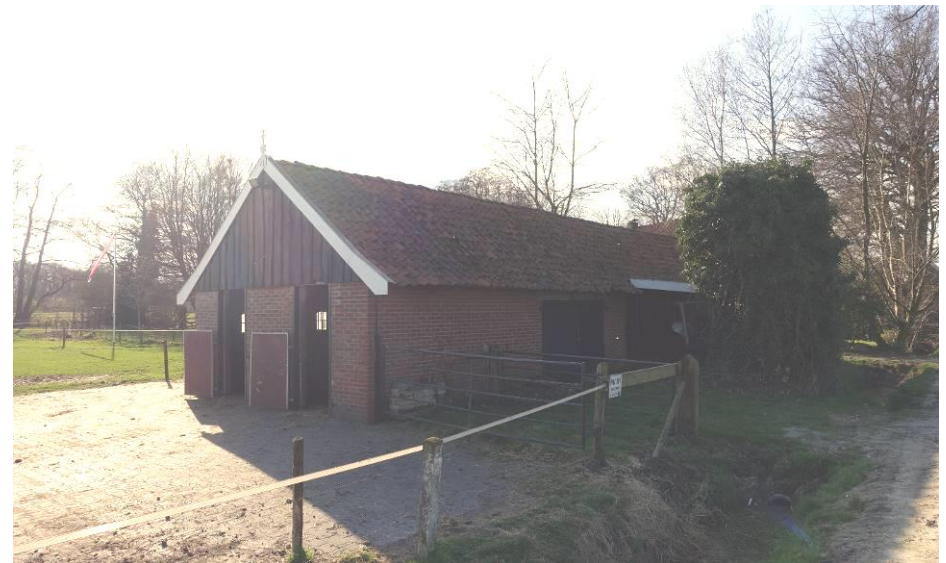
De paardenstalling Harberinksweg 43 heeft in de westelijke helft houten wanden op een gemetselde plint en aan de oostzijde bakstenen gevels met een houten geveltop (onder). FH MAB 2020.
