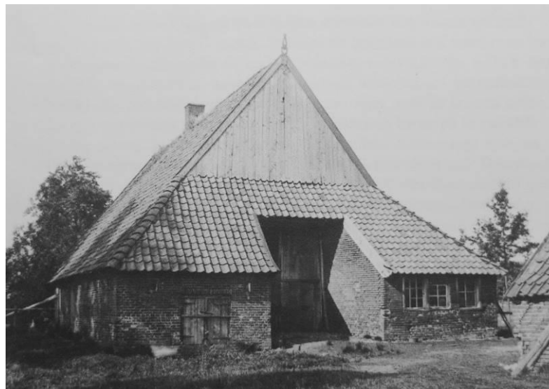
Achterzijde van een boerderij met uitgebouwde hoekschotten. De deeldeuren (niendeuren) liggen in het feitelijke vlak van de achtergevel maar toch onder een afdak, waardoor het een met een onderschoer vergelijkbare opzet heeft. Twentse-erven.nl
