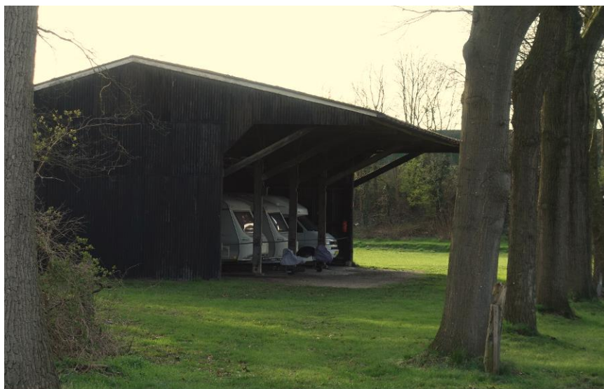
Keuperweg 80, wagenshuur vanuit het oosten gezien. FH MAB 2020
