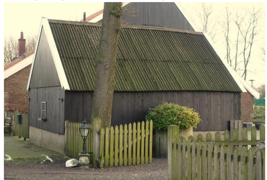
Rosinkweg 40. De kleine schuur aan de Rosinkweg, noordzijde. FH MAB 2020
