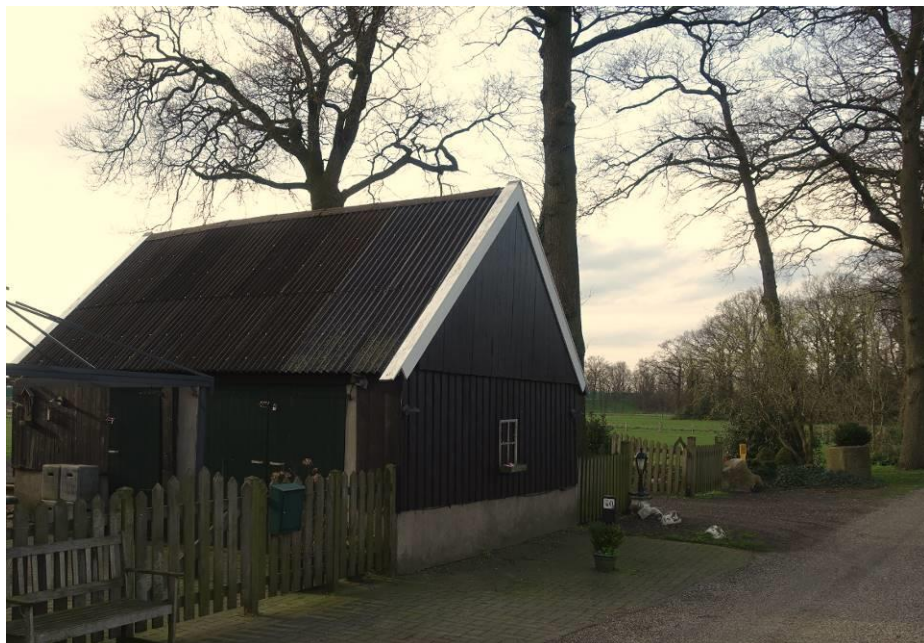
Rosinkweg 40. De kleine schuur aan de Rosinkweg, zuidzijde. FH MAB 2020
