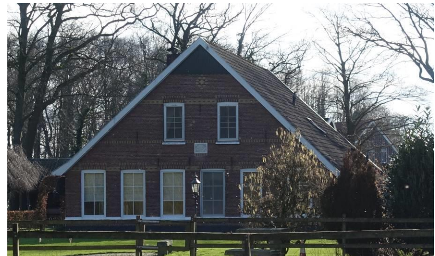
De voorgevel gezien vanaf de Keuperweg. FH MAB 2020
