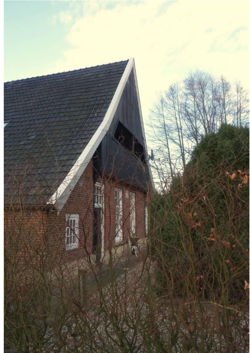
Rosinkweg 35, voorgevel boerderij vanaf de straat gezien. FH MAB 2020
