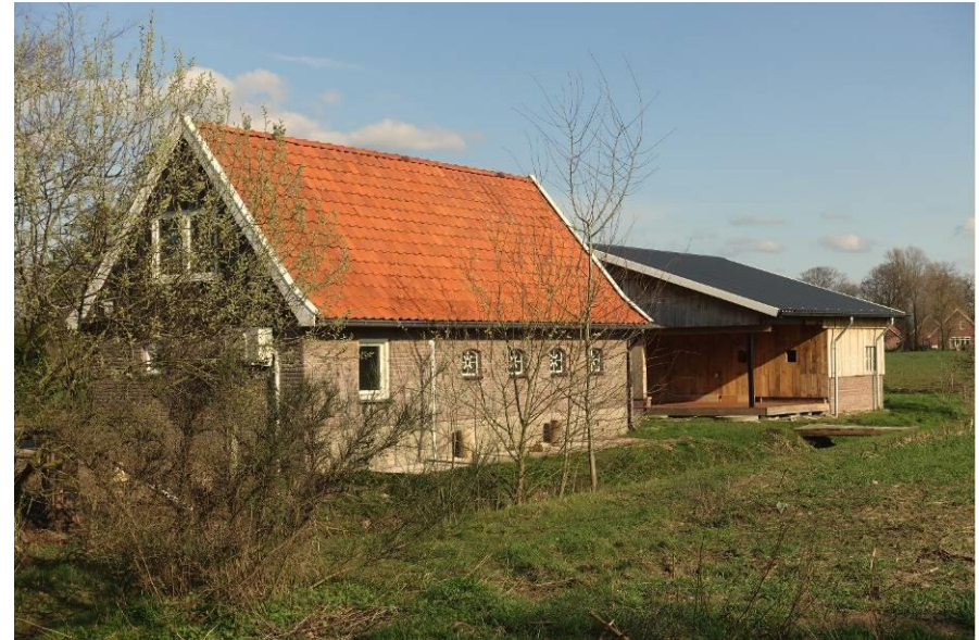
Harberinksweg 59 vanuit het westen gezien. FH MAB 2020
