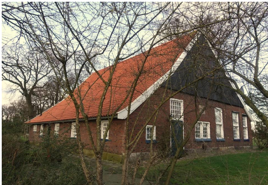
Rosinkweg 40. Voorgevel en linker zijgevel. FH MAB 2020
