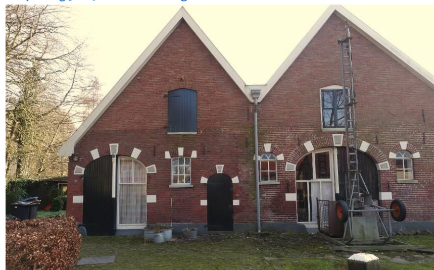
Keuperweg 3 en 5. De onderbouw rechts behoort tot een 19 de -eeuwse verbouwing en links is de uitbreiding van kort voor 1902. De topgevels zijn vermoedelijk rond 1920 versteend toen het voorhuis ook is uitgelegd. FH MAB 2020
