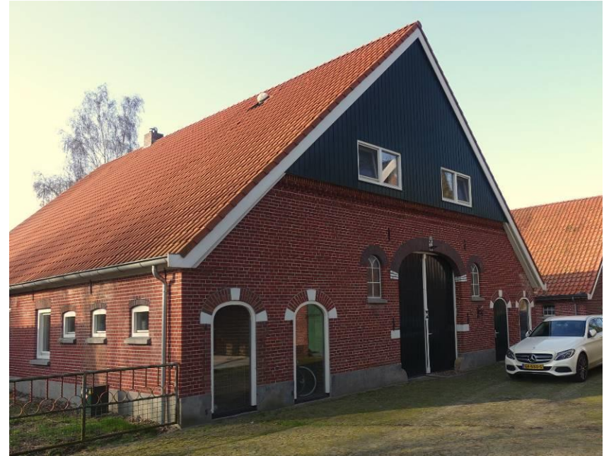
Harberinksweg 49. Achtergevel van de boerderij vanaf de Keuperweg gezien. FH MAB 2020.
