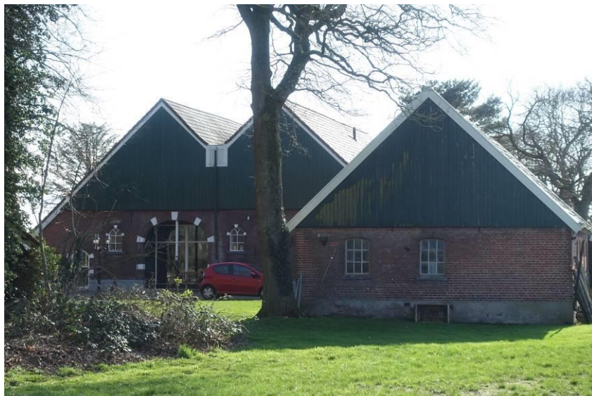
Harberinksweg 2 varkensschuur en boerderij vanuit het noorden gezien. FH MAB 2020
