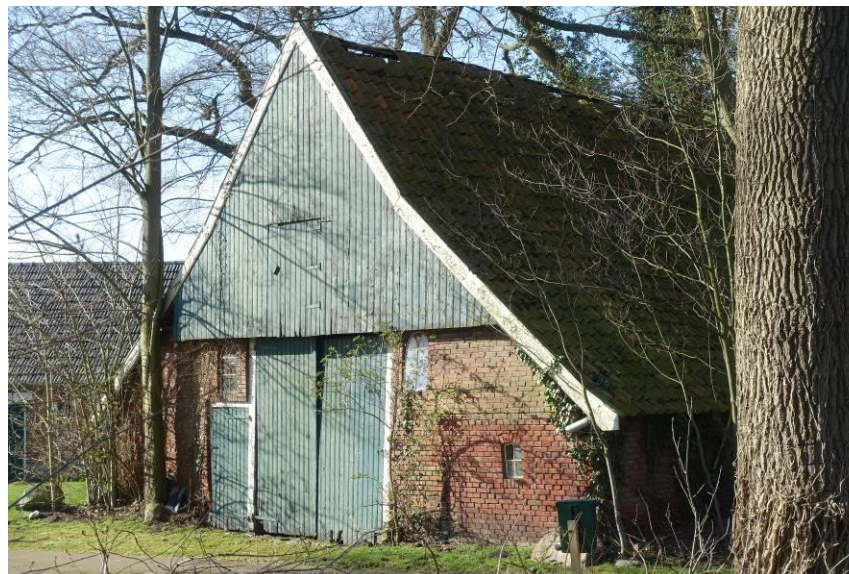
Harberinksweg 2, oude schuur, zuidoostgevel. FH MAB 2020
