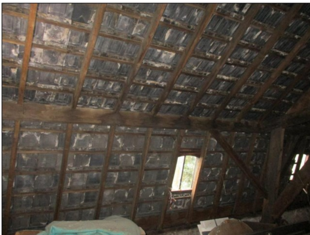
Figuur 2 Binnenzijde van de schuur.
