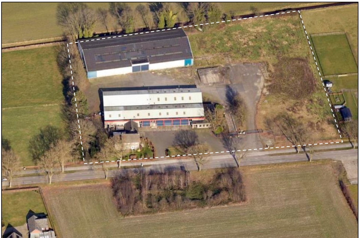
Figuur 3 Luchtfoto Statenweg 31-33 Venhorst
