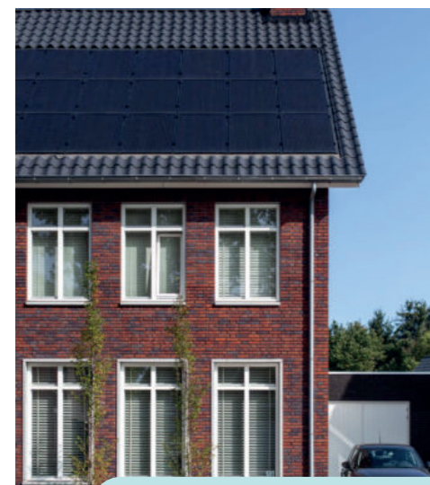
Donkere dak en witte kozijnkleur
