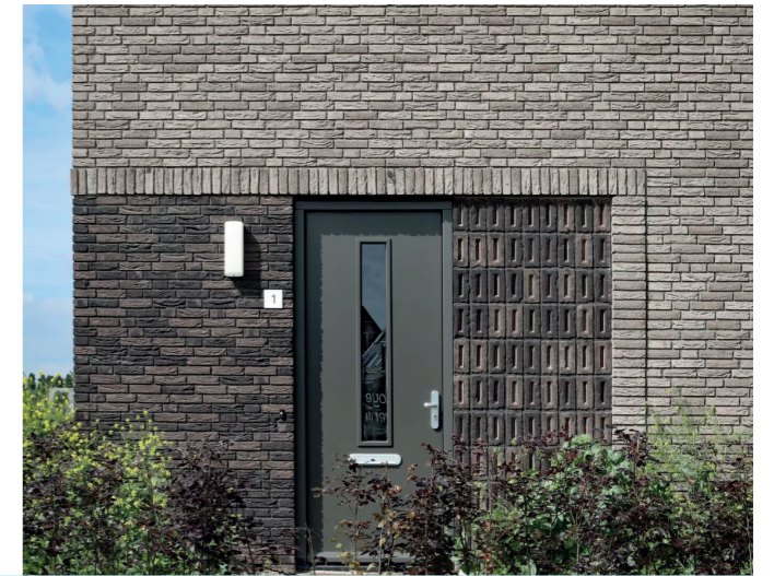
Metselwerkdetails als architectonisch accent
