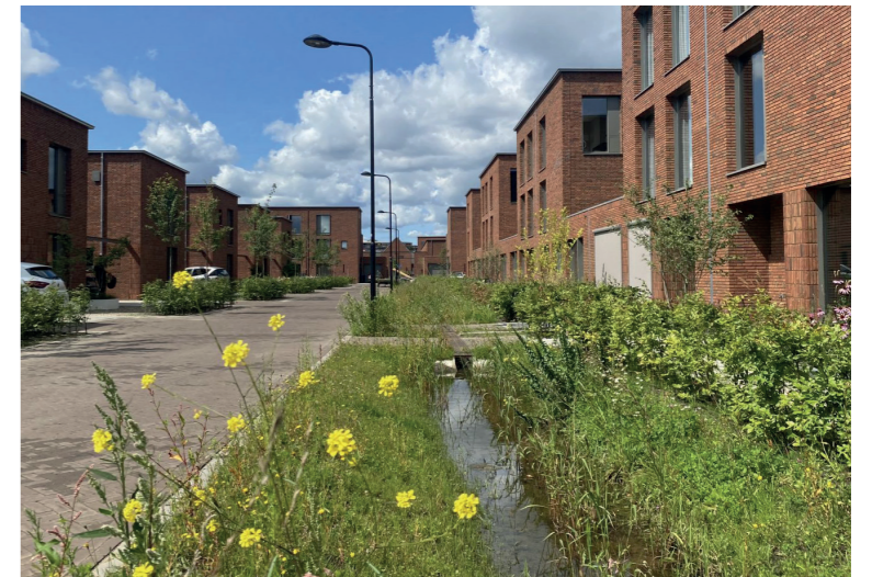
Waterafvoer via greppels
