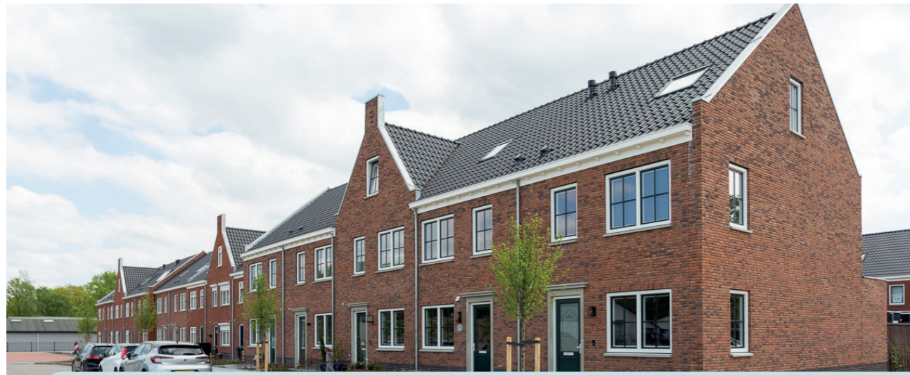
Samenhang versterkt door baksteenkleur en variatie in goothoogte.
