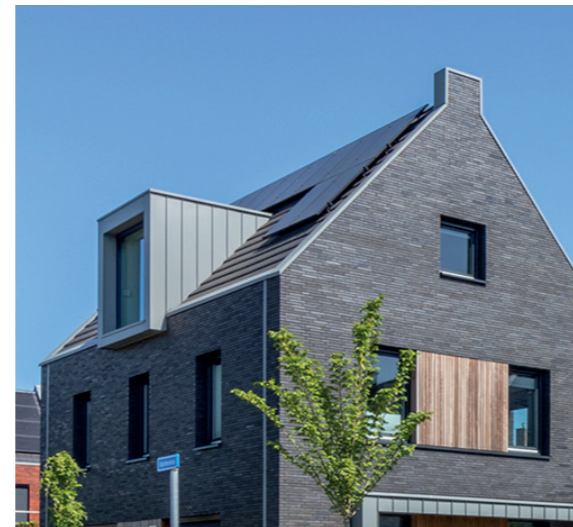
Geïntegreerde zonnepanelen en dakkapellen
