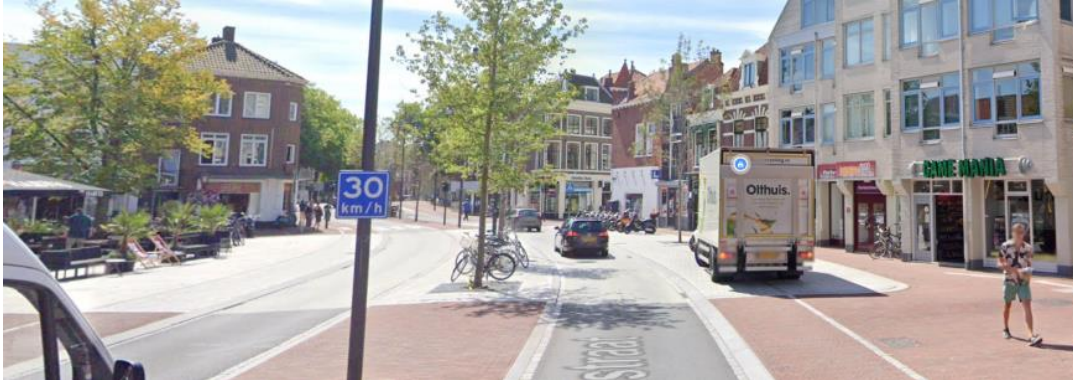
Referentiebeeld rijbaan in asfalt met materiaalovergang
