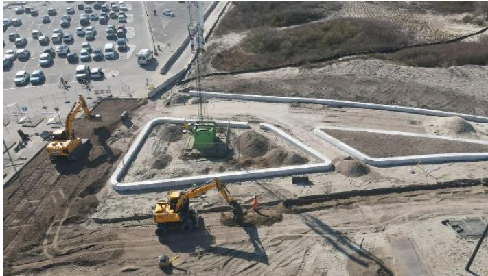
Werkzaamheden aan het Slag
