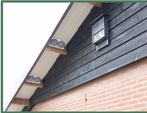
Afbeelding 29: Te behouden gevel, voorzien van een vleermuizenkast
