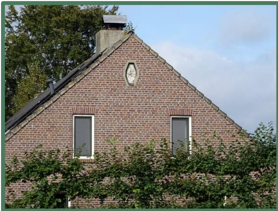
Mogelijk ruimte achter kantpannen naburige woning
