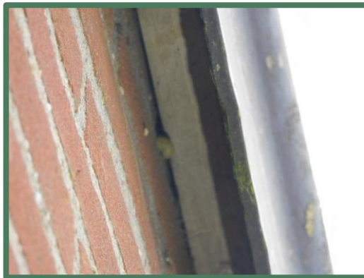
Afbeelding 23: Ruimte tussen wanden en windeveer gesloten met een panlat
