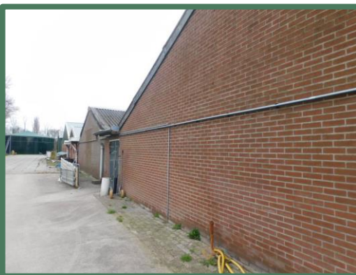
Afbeelding 9: Zijgevel van de varkenstallen vanaf het zuidwesten
