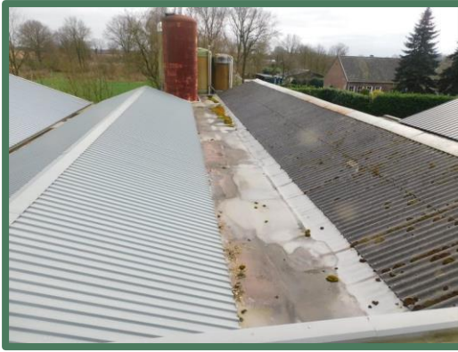
Afbeelding 26: Overzicht daken van de varkensstallen
