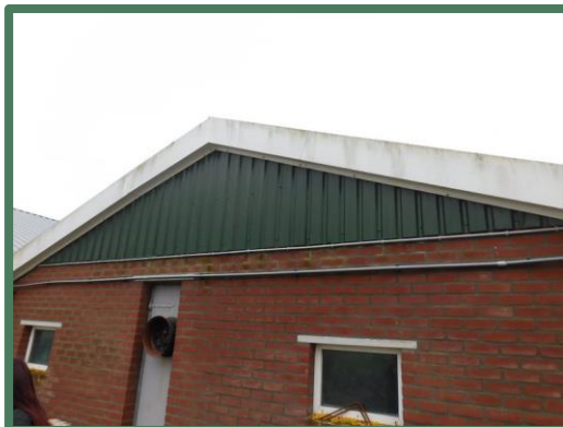
Afbeelding 10: Nok van de varkenstal
