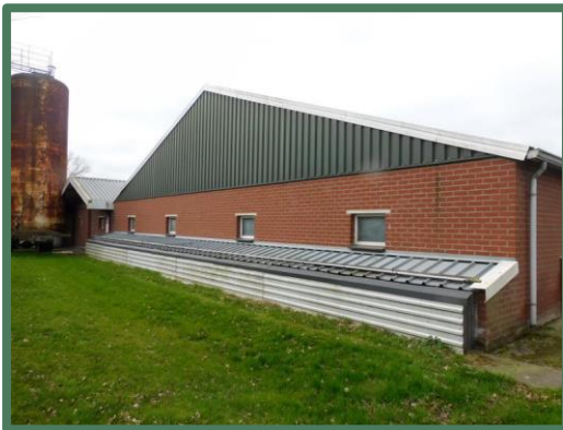
Afbeelding 14: Varkenstal vanaf het oosten
