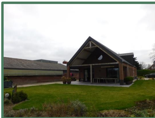
Afbeelding 7: Woonhuis vanaf het westen
