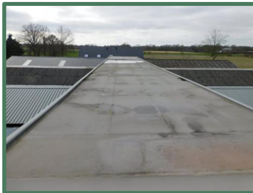
Afbeelding 25: Overzicht daken van de varkensstallen
