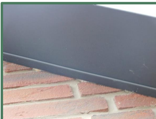
Afbeelding 30 en 31: Ruimte tussen het dak en de wanden van het woonhuis strak aangesloten
