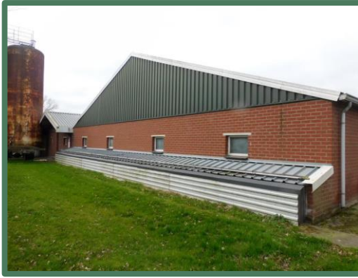
Afbeelding 27: Gesloten luchtzuiveringinstallatie
