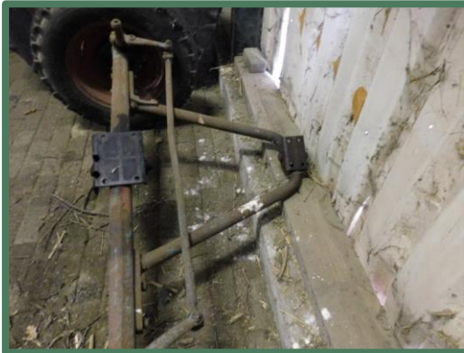
Afbeelding 32: Krijtsporen in het oosten van de loods
