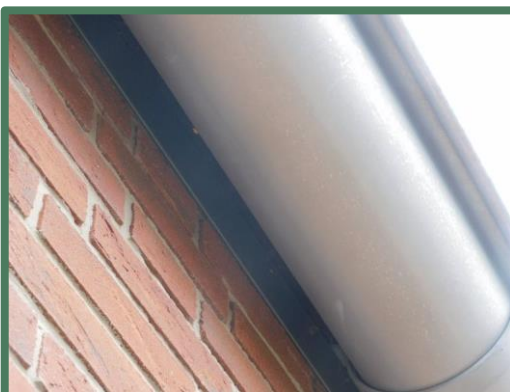
Afbeelding 30 en 31: Ruimte tussen het dak en de wanden van het woonhuis strak aangesloten
