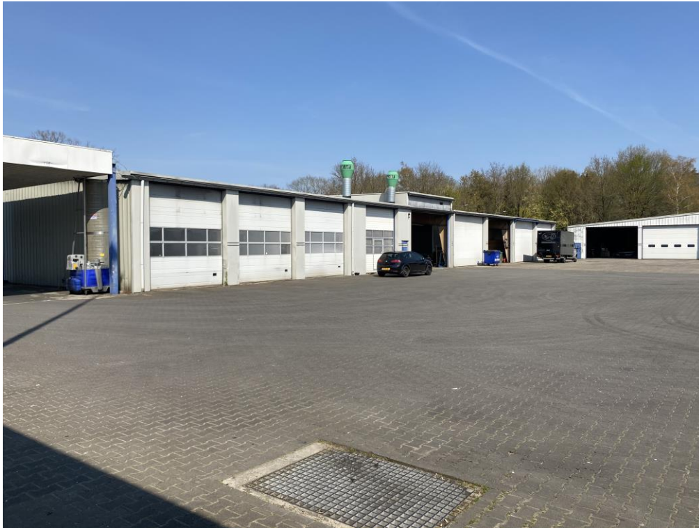
Achterzijde gebouw A
