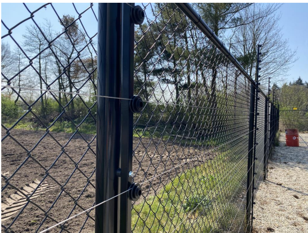
Nieuw hekwerk met bewegingsdetectie
