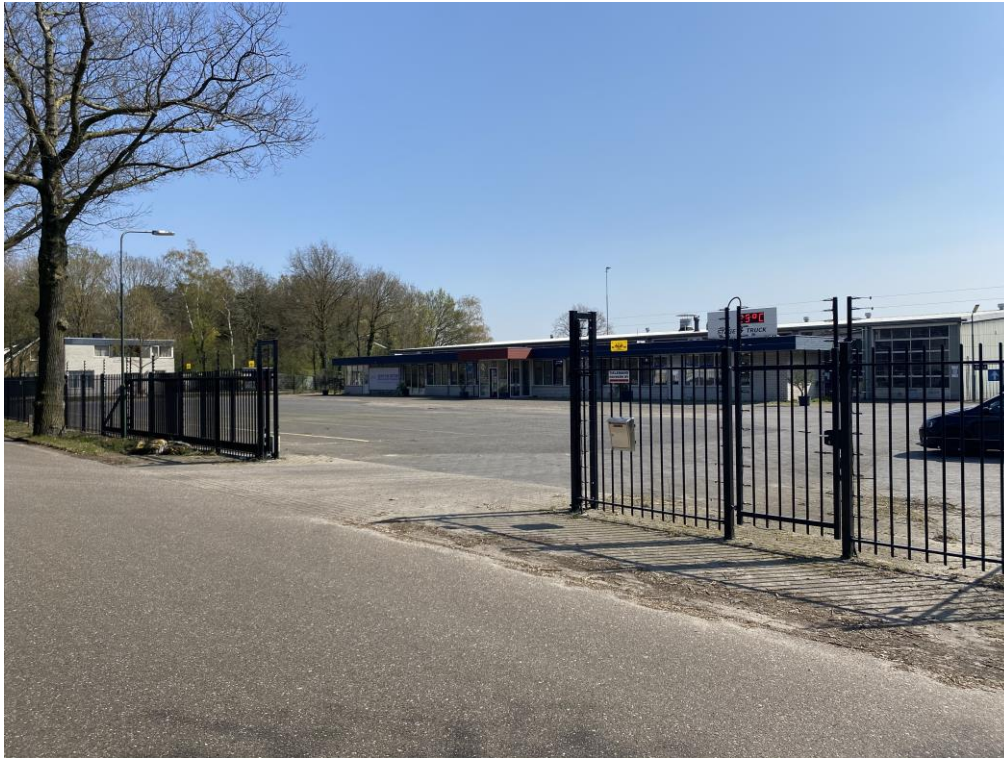
Voorzijde bedrijfslocatie met op de achtergrond gebouw A
