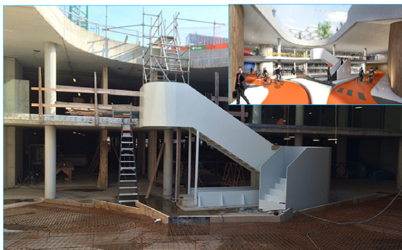
Realisatie 1 e fase Stationspleinstalling
