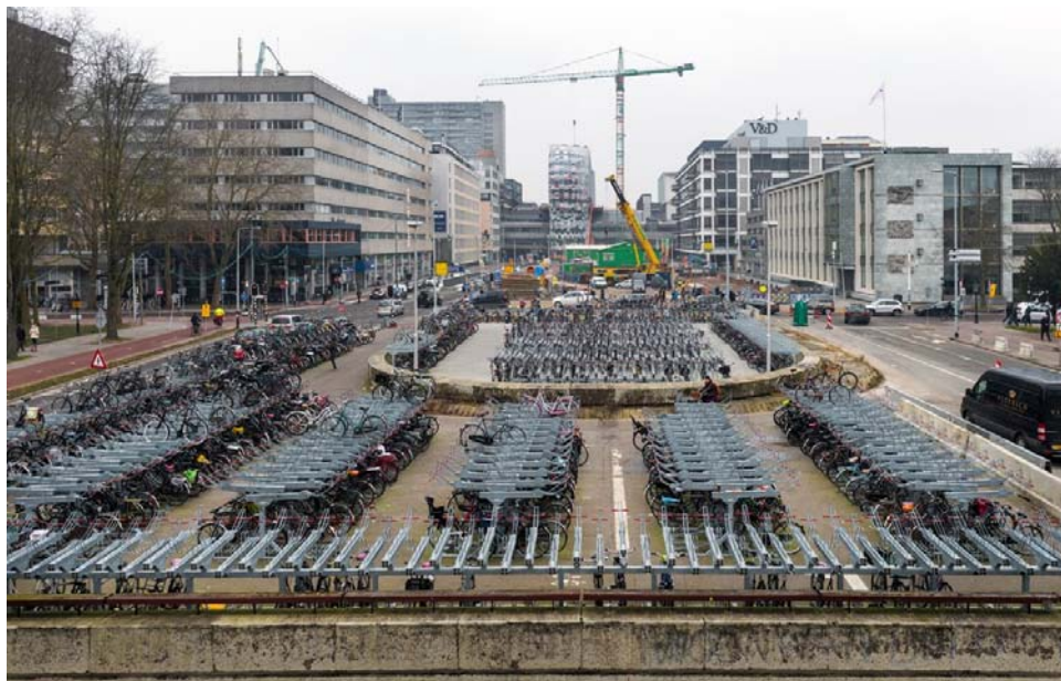
Uitgebreide tijdelijke stalling op het oude Willemsviaduct
