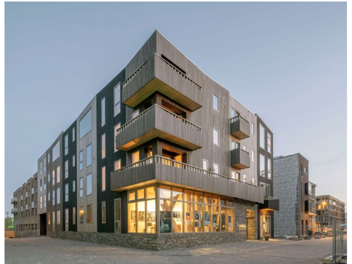
Afbeelding 199. Biobased materialen. Het gebouw is afgewerkt met een houten (deels bamboe) gevelbekleding en een natuurstenen rand. Het gebouw heeft een EPC (Energy Performance Coefficient) van -0,201, is rainproof en natuurinclusief. Het hemelwater wordt gebruikt voor de bewatering van de in het ontwerp verwerkte groene elementen. Amsterdam, Mooijburg, IJburg
