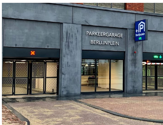
Afbeelding 38. Ingang parkeergarage. Berlijnplein, Utrecht
