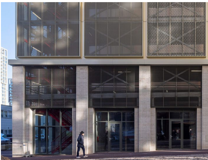
Afbeelding 41. Parkeergebouw onderdeel van het blok. Amsterdam, NDSM
