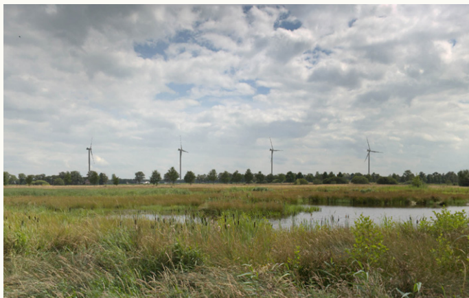
rijke landschappelijke structuur beperkt de dominantie van windturbines (beeld: ROM3D)
