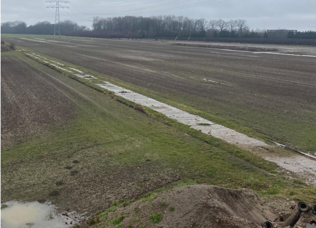
Deellocatie 07: Afperkend bodemonderzoek boring 208 pad 2
