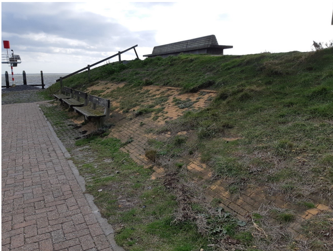
Afbeelding 19 Niet zichtbare bunker op de punt bij de Jachthaven. Bron: Vestigia (d.d. 8 november 2022).
