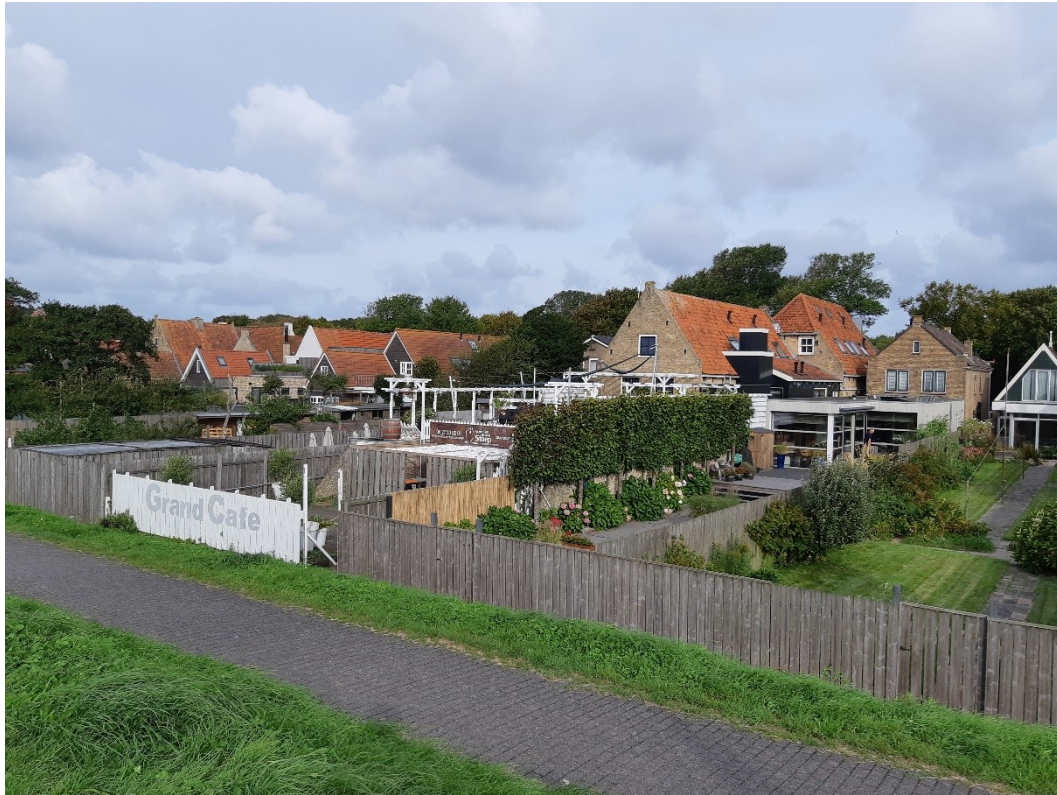
Abbeelding 49 Diepe achtertuinen en zicht op gevelwand achterzijde ter hoogte van Dorpsstraat 81. Foto: Vestigia, september 2023.
