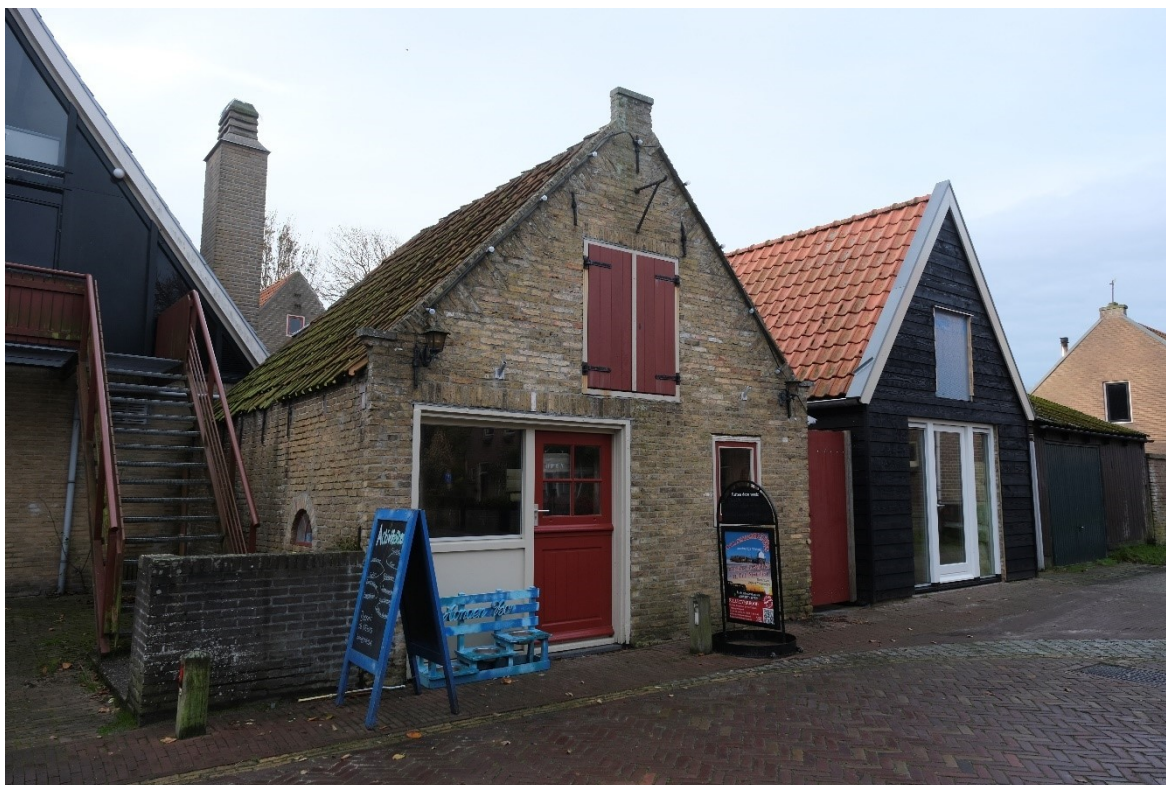
Afbeelding 59 Schuur uit 1780 (Kerkplein 11). Foto: Vestigia, november 2022.
