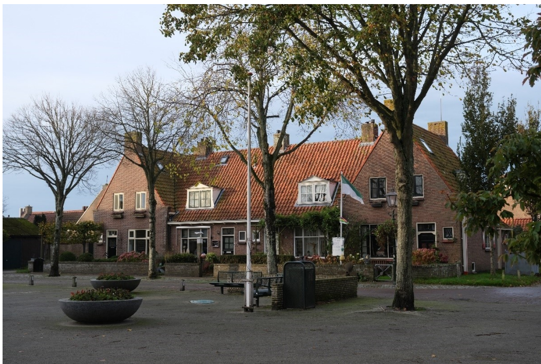
Afbeelding 62 Dubbelwoning in de stijl Delfts Rood uit 1954 (Kerkplein 1-4). Foto: Vestigia, november 2022.
