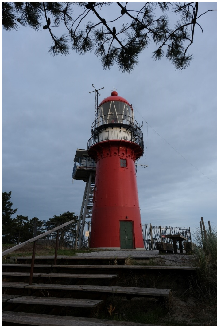
Afbeelding 54 De gietijzeren, in 1909 uit IJmuiden overgeplaatste vuurtoren boven op het Vuurboetsduin. Rijksmonument nr. 37578. Foto: Vestigia, november 2022.
