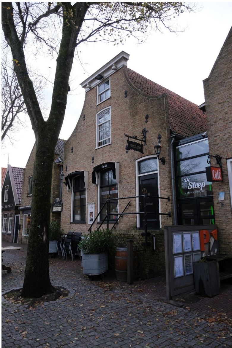
Afbeelding 75 Dorpsstraat 81, nu rijksmonument, maar in 1971 gesloopt en compleet nieuw opgebouwd (opm. stakeholders). Foto: Vestigia, november 2022.
