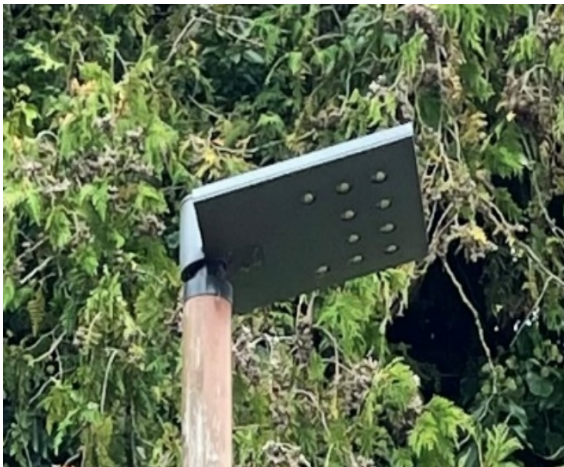
Bij het gemeentehuis zijn speciale armaturen toegepast.
