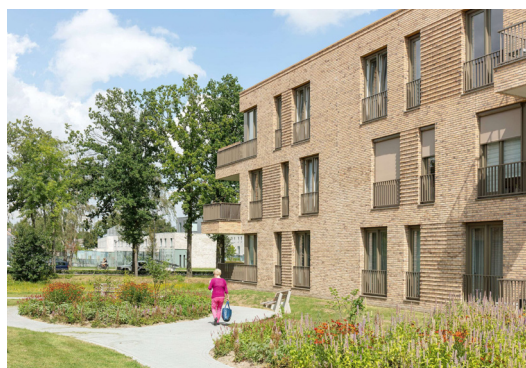
Inpandige buitenruimte direct grenzend aan openbare ruimte afgeschermd met hekwerk
