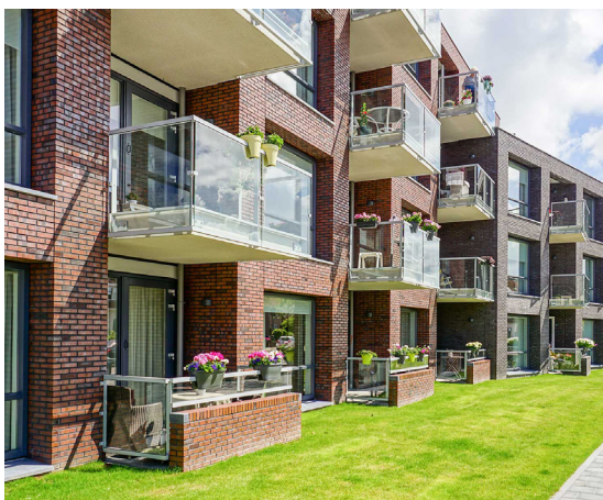
Inpandige buitenruimte afgeschermd met lage gemetselde muur
