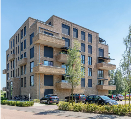
Balkons voorzien van metselwerk
