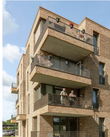
Balkons metselwerk en hekwerk
