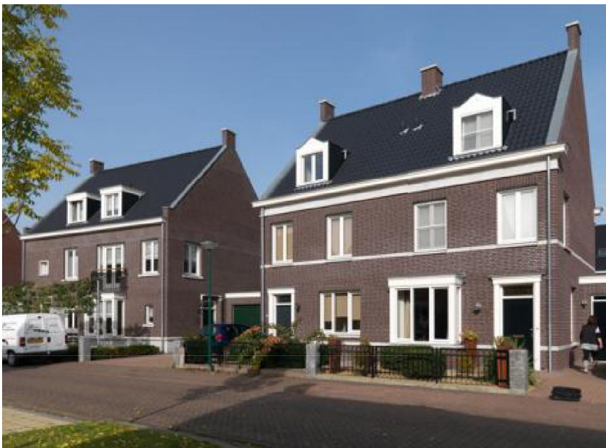
Afwisseling in gootdetailering en onderstreping van daklijsten.
