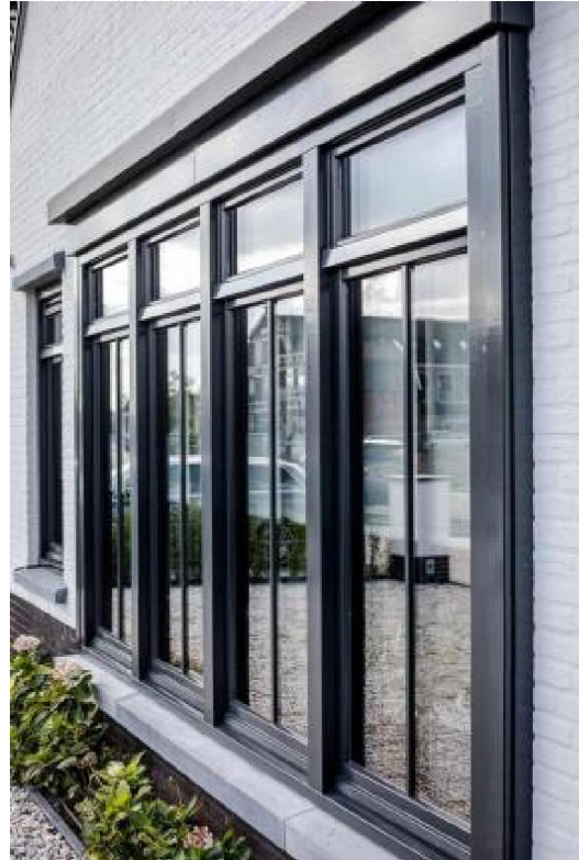
Verzwarend van kozijnhout, bijvoorbeeld ter plaatse van een bloemenraam.
