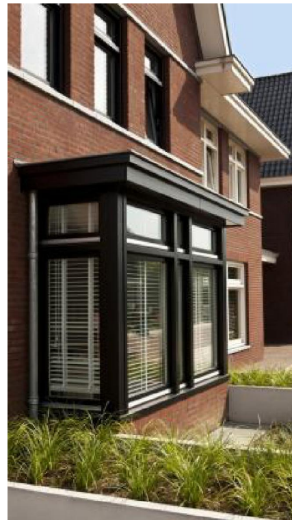
Afwisseling in detaillering architectonische onderdelen.
