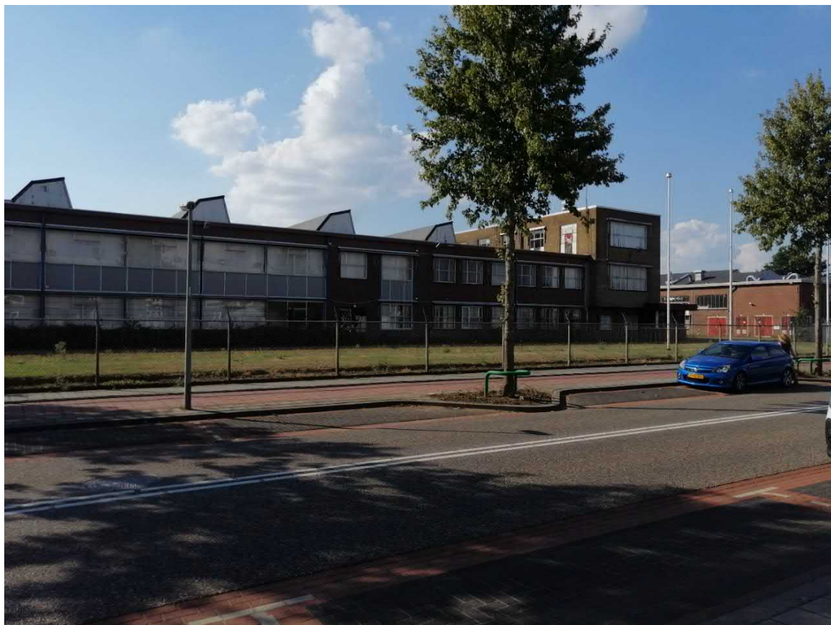
Figuur 23 De gevel bij de hoofdingang aan de Bredeweg met een modernistische gevel die vóór de oude gevel is geplaatst, nummer 1. Rechts op de foto is het entreegebouw te zien.
