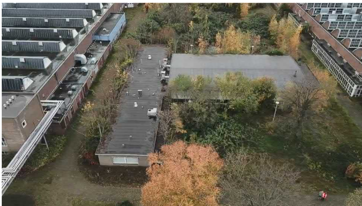
Figuur 26 Het kantinegebouw met personeelswinkel, herbouwd na de brand in 1963.
