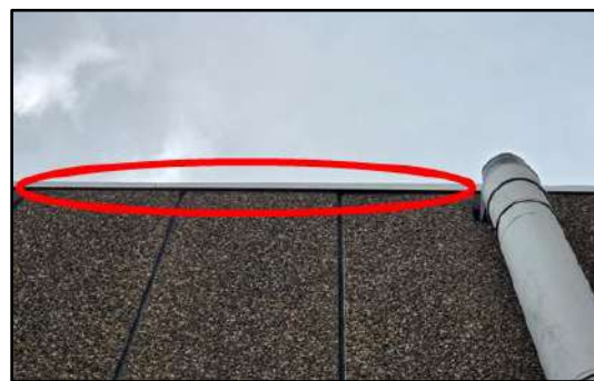
Afbeelding 4: ruimte bij dakrand
