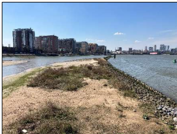
Figuur 7. Bestaande strekdam vanaf het westelijke deel van het Eiland van Brienenoord. Westelijke kijkrichting.
