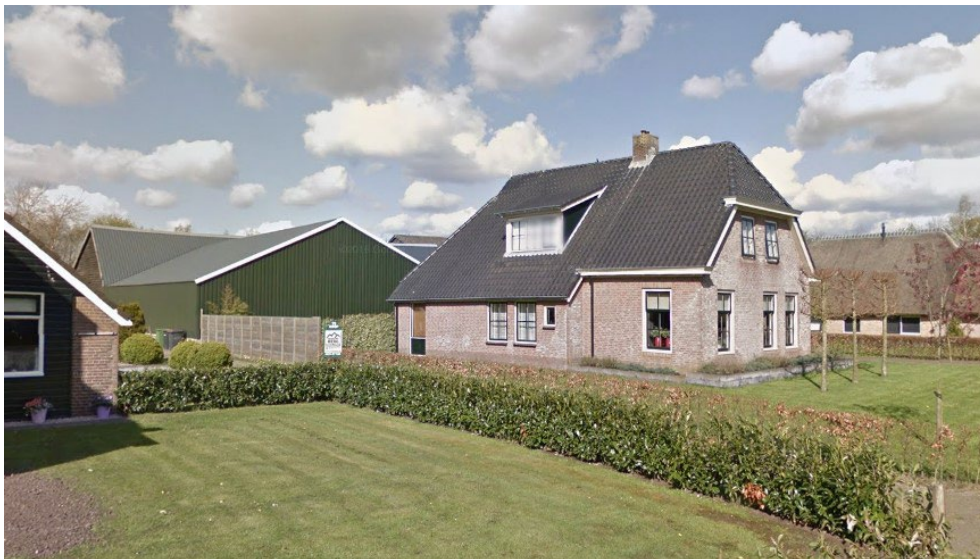
Zijgevel van De Hoek 37 met linksachter de bedrijfsbebouwing van het achterliggende bedrijfsperceel
