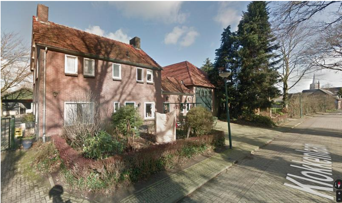
Impressie bestaande situatie Klokkenlaan 30-32
