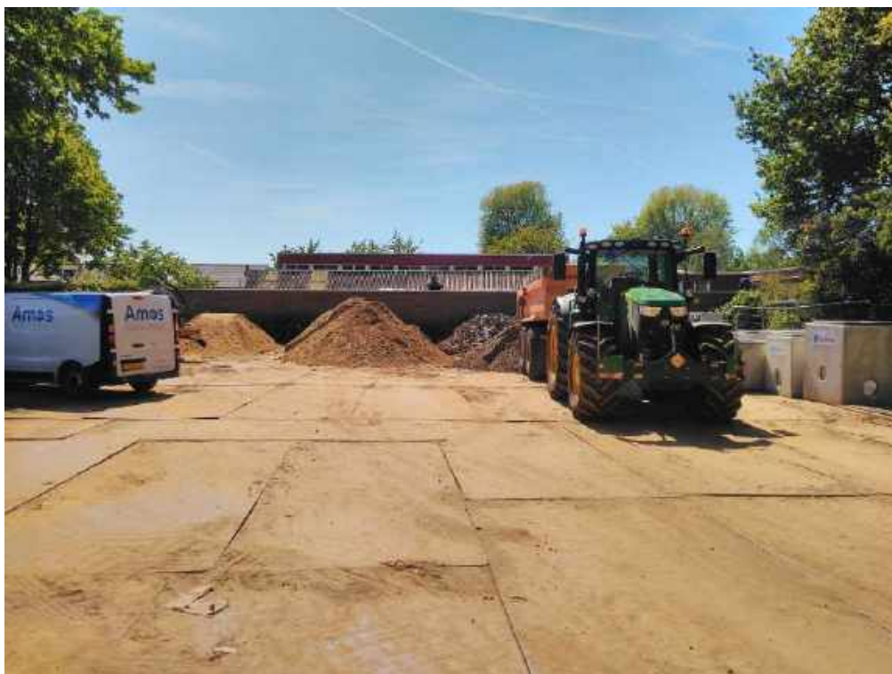
Foto 2: overzicht, perceel 2101, opslag materiaal i.v.m. rioleringswerkzaamheden Molenstraat
