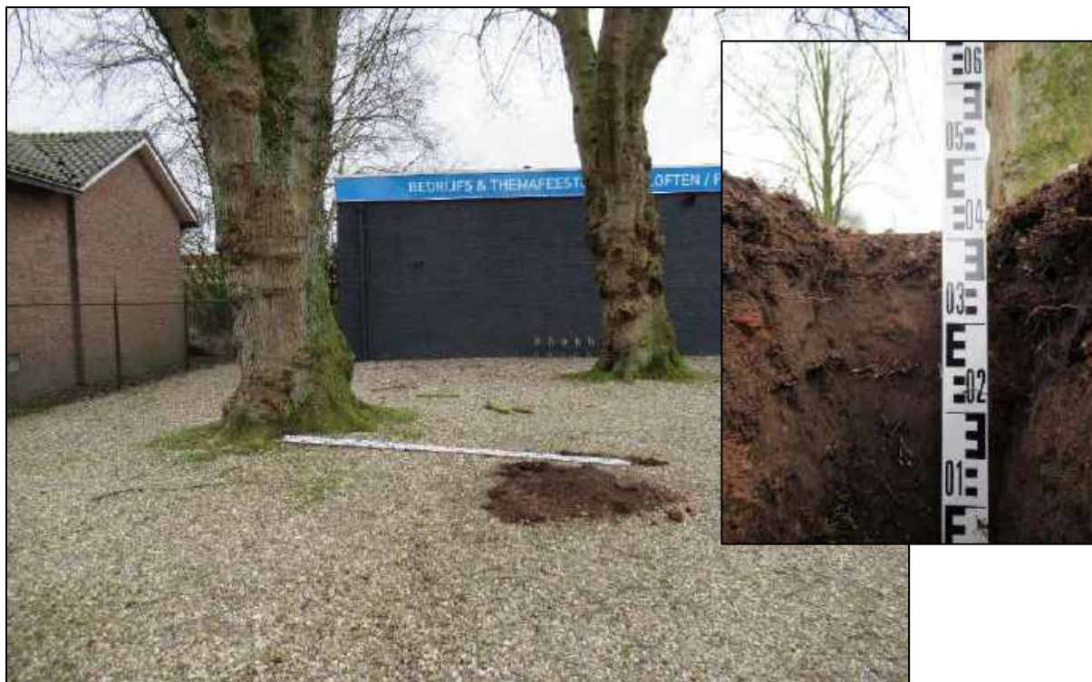
Foto 13: Locatie proefsleuf boom 2 Inzet: bovenaanzicht proefsleuf
