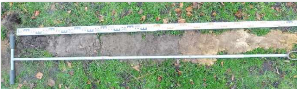
Foto 5: beeld van bodemopbouw onder de verharding
