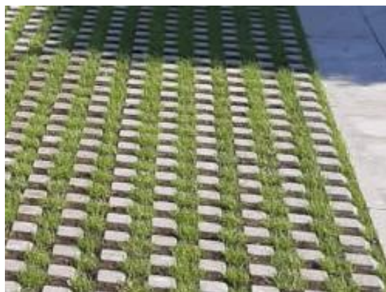
referentie 6.22: half verharde parkeerplaatsen
