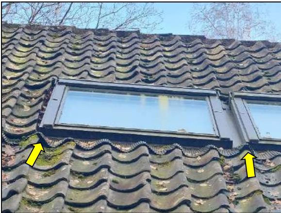
Figuur 18. Ruimte onder de loodflappen.
