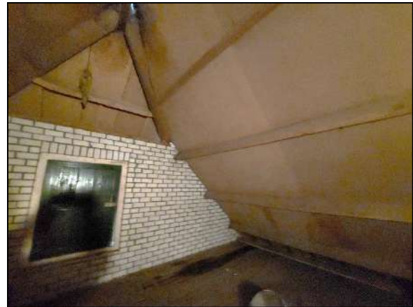
Figuur 19. Zolder van de bebouwing.
