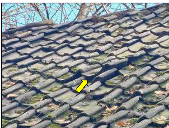
Figuur 14. Ruimtes onder de dakpannen.
