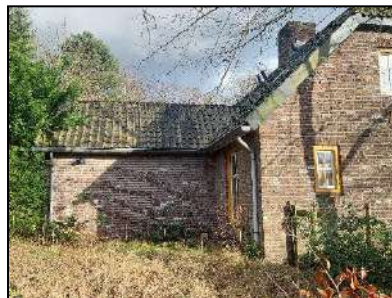
Figuur 7. De westzijde van de onderzoekslocatie.
