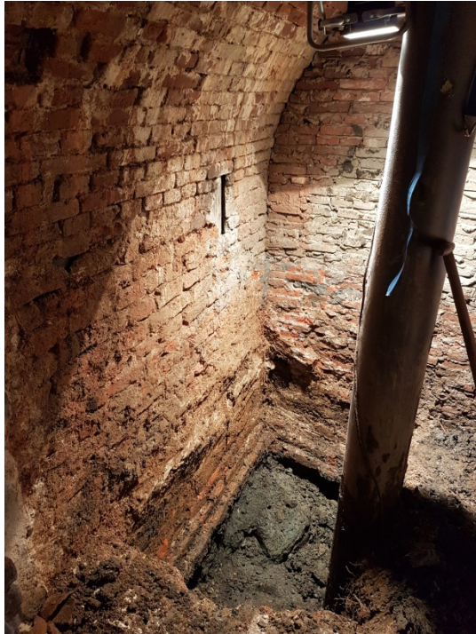
Figuur 49 – foto proefsleuf vrijgegraven groutpaal en schets opbouw fundering brugkelder
