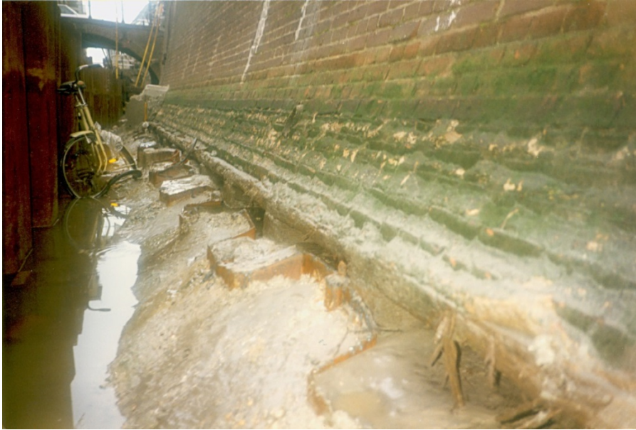
Figuur 26 – foto renovatiewerkzaamheden jaren '80. Stalen damwand en onderwaterbeton aangebracht direct voor de fundering van een kademuur op de Drift. De muur is bij de fundering verbreed met een aantal versnijdingen. In de damwandkassen zijn houten kessen zichtbaar.
