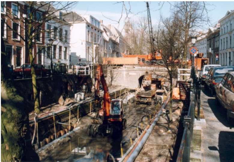
Figuur 6 – overzichtsfoto aanleg grachtriool op de Nieuwegracht (midden '80-er jaren)
