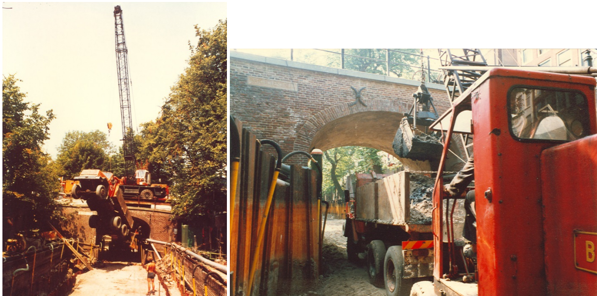
Figuur 24 – uitvoeringsfoto's aanleg grachtriool begin jaren '80. Een werkwijze die we met de huidige inzichten niet meer aan zouden durven
