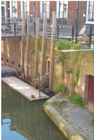
Stutconstructie bij beschadigde muur kelder 68
