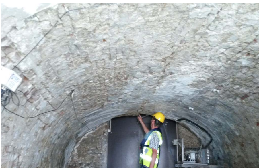
Figuur 55 – foto van kluiskelder Kromme Nieuwegracht 62-2: in de top van de boog is een scharnier waarneembaar over de gehele lengte van de kelder. De foto is genomen in de richting van het water. Bij het vrijgaven van de bovenzijde kwamen er overigens meer verontrustende constructieve schades naar voren.
