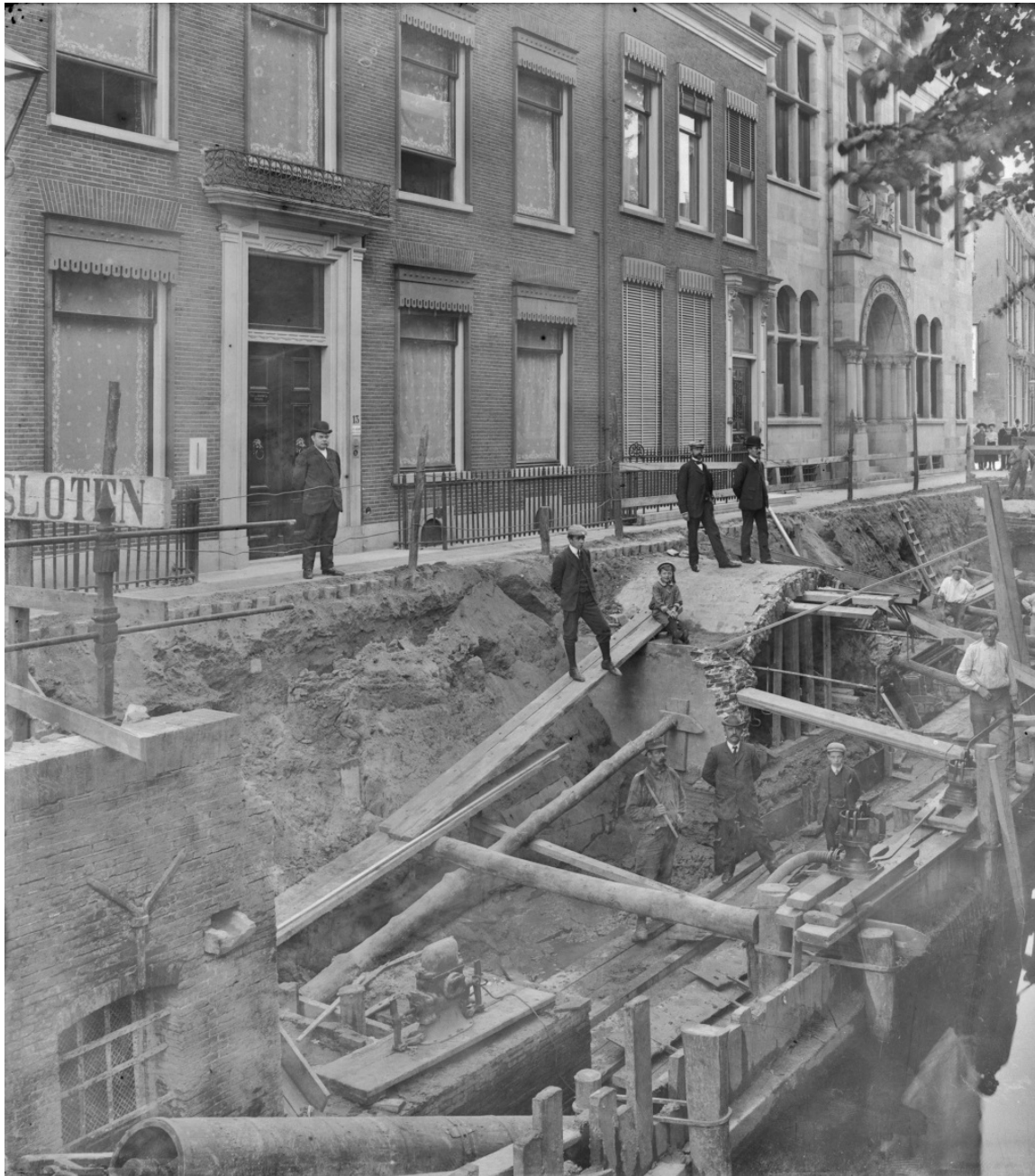
Figuur 16 – calamiteiten zijn gelukkig een uitzondering. Hier een foto van de wederopbouw van een groot stuk kademuur en kluismuur ter hoogte van de Drift 9 nadat deze in 1908 bezweek.
