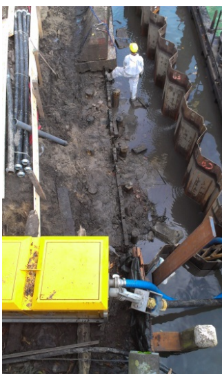
Figuur 11 – foto's uitvoering Oudegracht. Achtereenvolgens: (1) uithijzen losgezaagde walmuur; (2) nevenriool onder boom; (3) oud palenplan zichtbaar; (4) drukken definitieve damwand met een silent piler systeem; (5) definitieve damwand en inhijzen prefab betonschort met metselwerk
