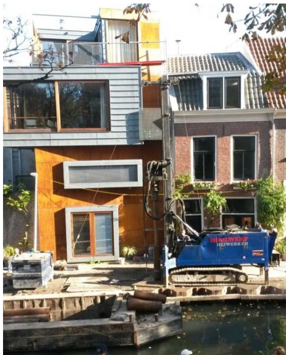
Figuur 42 – voor de passage van belendingen (hier de Boog) en bomen, maar ook bij smalle werven, wordt de palenwandmethode gebruikt. De bouwkuip wordt met zand uitgevuld en het metselwerk van de walmuur wordt met een kernboor of vergruizende boor verwijderd. In de ruimte die ontstaat worden stalen palen mannetje-aan- mannetje geplaatst
