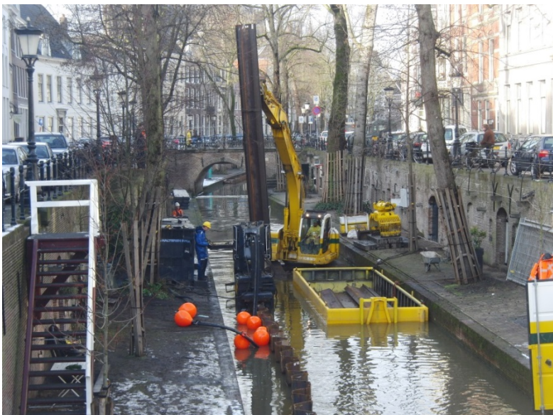
Figuur 7 – overzichtsfoto renovatie rak 16 (winter 2015–2016)
