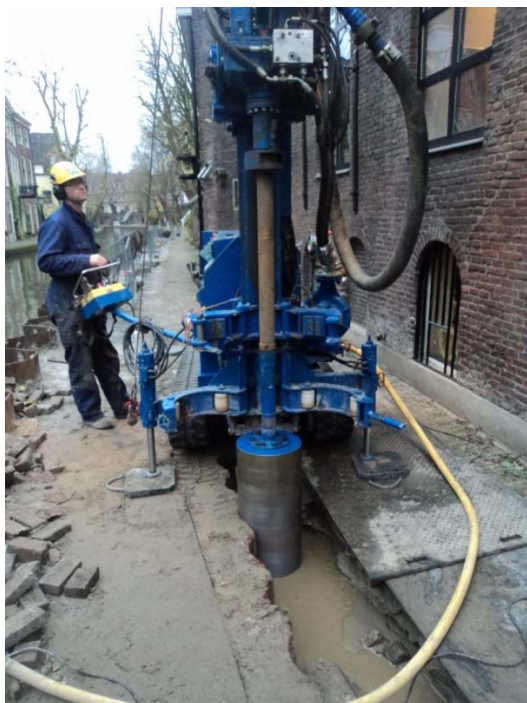
Figuur 42 – voor de passage van belendingen (hier de Boog) en bomen, maar ook bij smalle werven, wordt de palenwandmethode gebruikt. De bouwkuip wordt met zand uitgevuld en het metselwerk van de walmuur wordt met een kernboor of vergruizende boor verwijderd. In de ruimte die ontstaat worden stalen palen mannetje-aan- mannetje geplaatst
