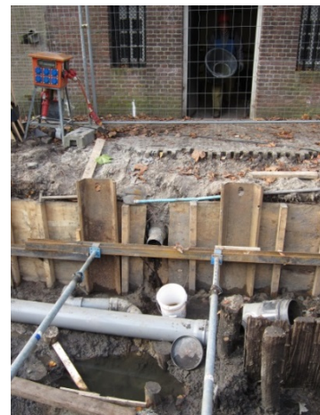
Figuur 13 – situatie tijdelijke wand. Achtereenvolgens (1) grote hoeveelheid boomwortels in lijn van tijdelijk scherm; (2) en (3) werken achter tijdelijk scherm
