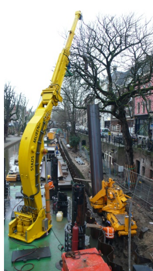
Figuur 11 – foto's uitvoering Oudegracht. Achtereenvolgens: (1) uithijzen losgezaagde walmuur; (2) nevenriool onder boom; (3) oud palenplan zichtbaar; (4) drukken definitieve damwand met een silent piler systeem; (5) definitieve damwand en inhijzen prefab betonschort met metselwerk
