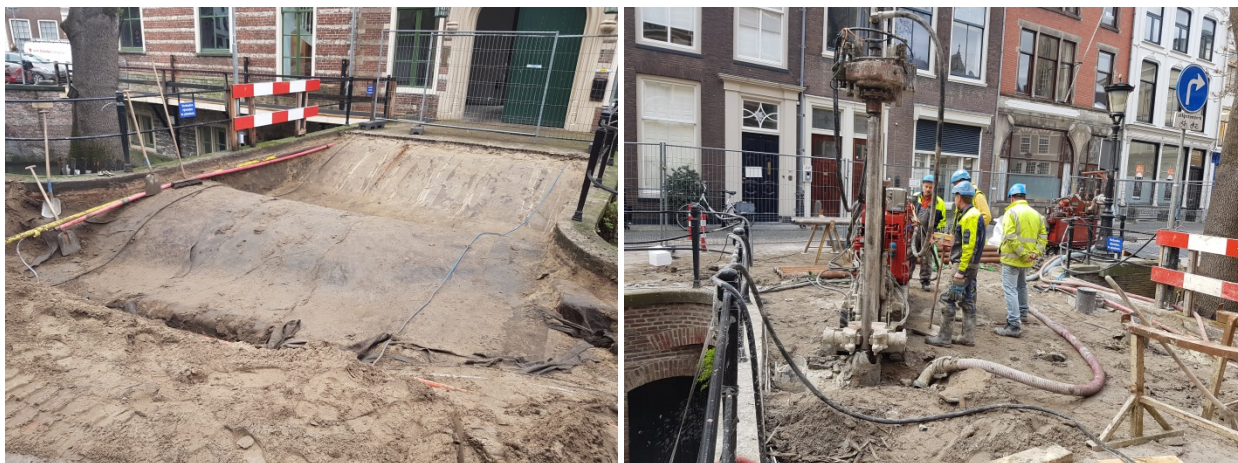
Figuur 47 – vrijgegraven boog van de toegangsbrug en aansluitende brugkelder & aanbrengen grout.
