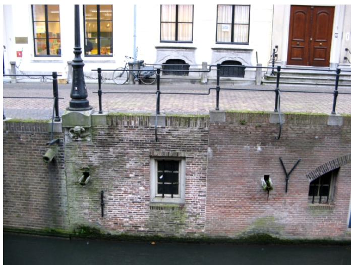
Foto 1 Kluismuur op de Plompetorengracht
