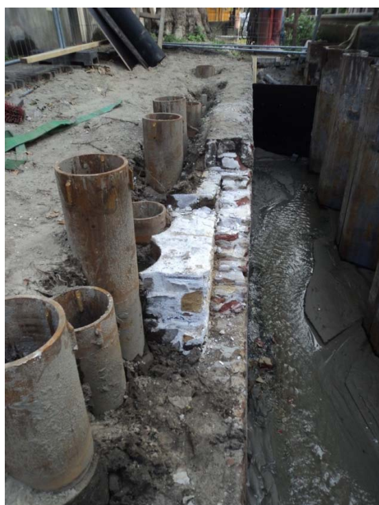
Figuur 43 – de bouwkuip wordt vervolgens ontgraven en de voorzijde van de oude gemetselde walmuur wordt verwijderd (links). Tussen de stalen palen worden stalen hoekprofielen gedrukt en gelast. Als laatste wordt in het werk een betonschort gestort en met metselwerk afgewerkt.
