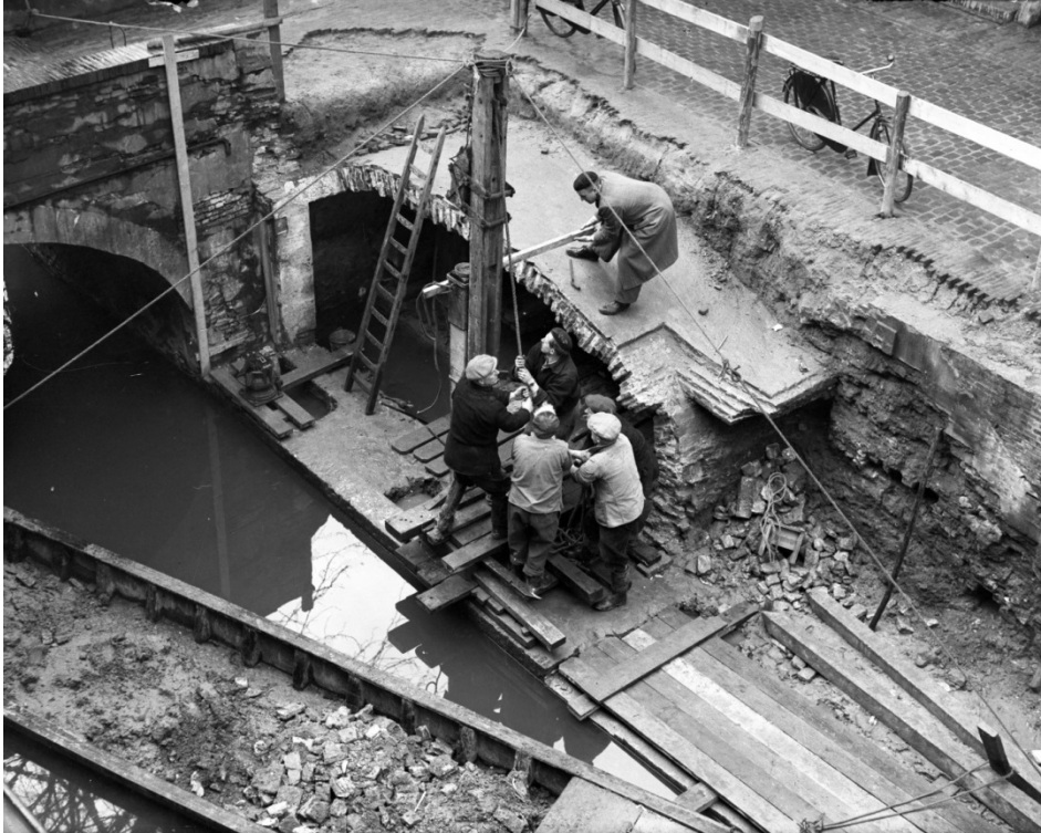
Figuur 21 – foto van de sloop van een gedeelte van een werfkelder aan de Kromme Nieuwegracht 22 (Pieterstraat) voor de aanleg van een werf waar een transformatorhuis moet komen, foto genomen op 6-3-1952. Op deze foto is goed te zien dat niet in alle gevallen een dikke steunmuur is aangebracht. Aangenomen wordt dat deze kelder later tegen een naastgelegen reeds aanwezige kelder met dikke steunmuur is opgetrokken. Deze stelling is echter moeilijk te verifiëren aangezien er heden geen direct naastgelegen kelder aanwezig is. Eerst is de muur (1½ steens?) tot de geboorte gemaakt waarna het gewelf is gemaakt. De ruimte tussen de oude kelder en de in aanbouw zijnde kelder wordt gevuld met bouwresten en puin. Nadat deze uitvulling op hoogte was werd de aanrasering gemetseld van stenen/plavuizen en werd het geheel vertind . Dat dit geen uitzondering is bleek bij het funderingsherstel van de kluiskeiders bij het Stadhuis. Bij het boren van de gaten om de grondverbetering met een groutinjectie (HP-groutinjectiesysteem) aan te brengen stuitte de aannemer meerdere keren op een puinvulling.
