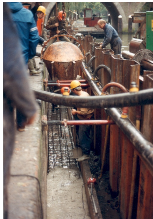
Figuur 5 – foto impressie van de aanleg van het grachtriool. (1) laat de huisaansluiting zien die op het grachtriool is aangebracht; (2) laat de betonstort van het aangelegde grachtriool zien.
