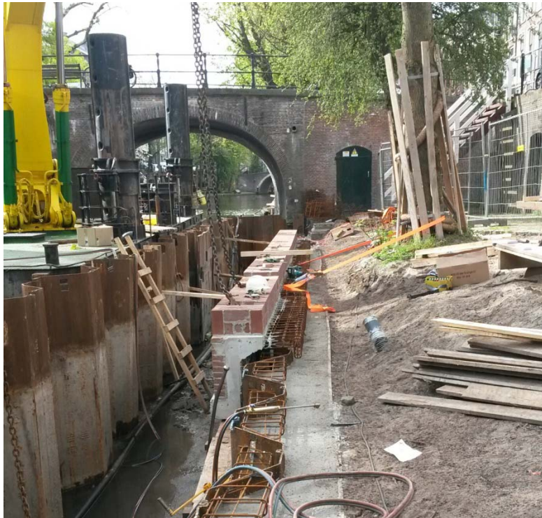
Figuur 40 – de definitieve damwand wordt afgewerkt met een prefab metselwerkschort, de bouwkuipdamwand wordt onder water afgebrand en stabiliseert daarmee de grachtriolkoffer.
