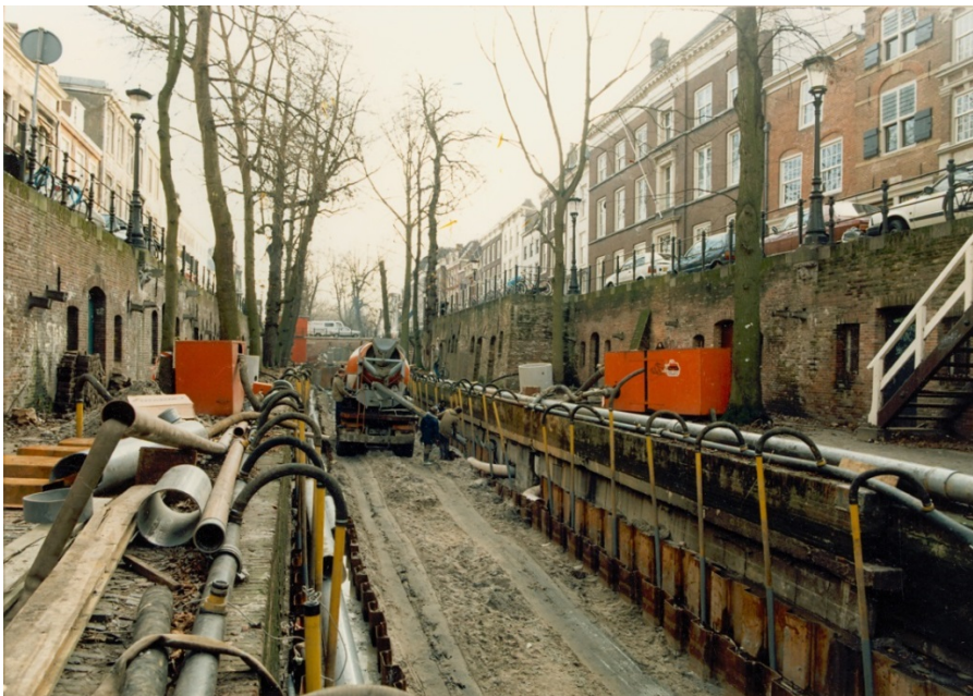
Figuur 27 – Bij de aanleg van het grachtriool in de Nieuwegracht op rak 19 is de gracht met een grote bronbemaling droog gezet. Het grachtriool is aangebracht tussen dunne stalen damwanden. Aan de rechterzijde is te zien hoe de walmuren halverwege de '60-er jaren zijn gebouwd op betonnen damwanden met een betonkop met voorbemetseling. Deze constructievorm is bij de renovatie behouden en enkel gestabiliseerd.
