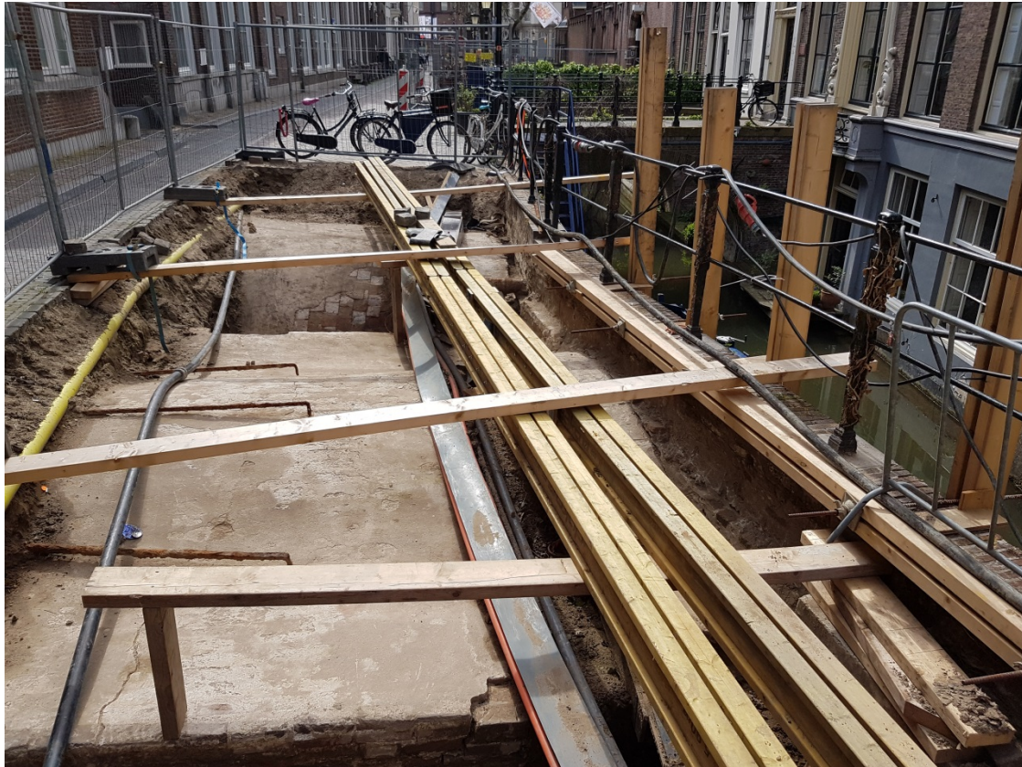
Figuur 52 – foto vrijgegraven kluiskelder Kromme Nieuwegracht 61 (voorzijde) en werfkelder Kromme Nieuwegracht 68-2 (achterzijde). Bij de achterste kelders zijn de plavuizen/ estriken goed zichtbaar die als afdekking van het gewelf zijn aangebracht. Kelder KNG 68-1 is opgebouwd uit grote stenen. Aan de voorzijde is een massieve muur aangebracht met daarop een aanrasering .
