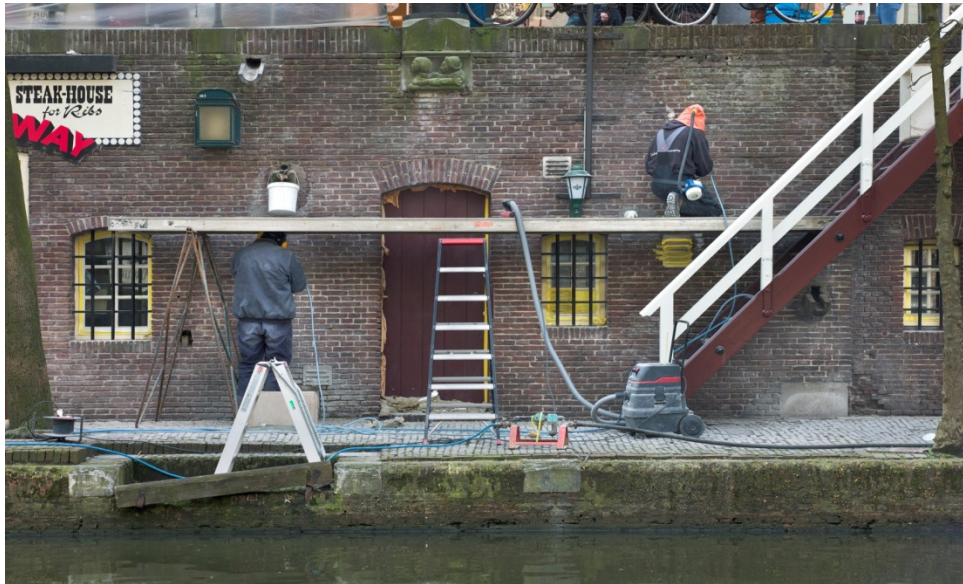
Figuur 34 – het herstel van de werfmuren omvatte met name het herstel van scheuren en ornamenten in de muren en het vernieuwen van kozijnen.
