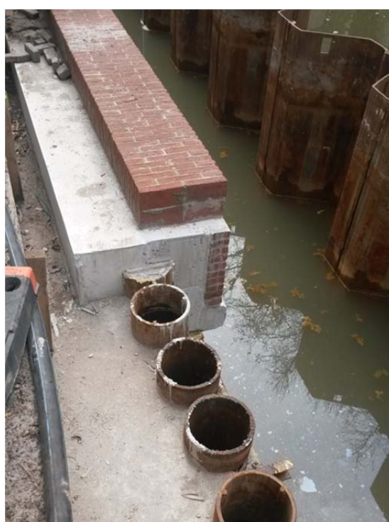
Figuur 43 – de bouwkuip wordt vervolgens ontgraven en de voorzijde van de oude gemetselde walmuur wordt verwijderd (links). Tussen de stalen palen worden stalen hoekprofielen gedrukt en gelast. Als laatste wordt in het werk een betonschort gestort en met metselwerk afgewerkt.
