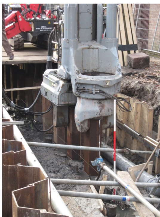
Figuur 39 – de walmuur wordt ontmanteld, vervolgens wordt tussen de oude houten funderingspalen een stalen damwand aangebracht: hier wordt de damwandmethode toegepast
