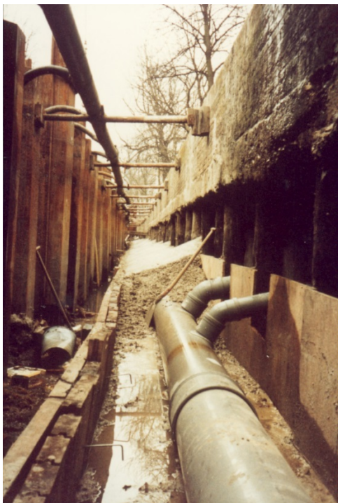
Figuur 5 – foto impressie van de aanleg van het grachtriool. (1) laat de huisaansluiting zien die op het grachtriool is aangebracht; (2) laat de betonstort van het aangelegde grachtriool zien.
