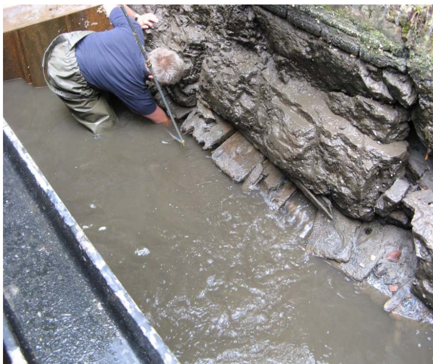
Figuur 37 – onderzoek aan de walmuren in 2008 heeft geleid tot een grootschalige renovatie van de walmuren
