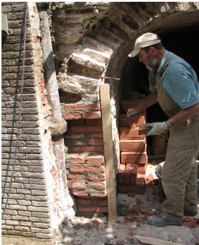
Figuur 35 – in sommige gevallen werd de gehele werfmuur geheel opnieuw opgebouwd zoals te zien op deze foto.
