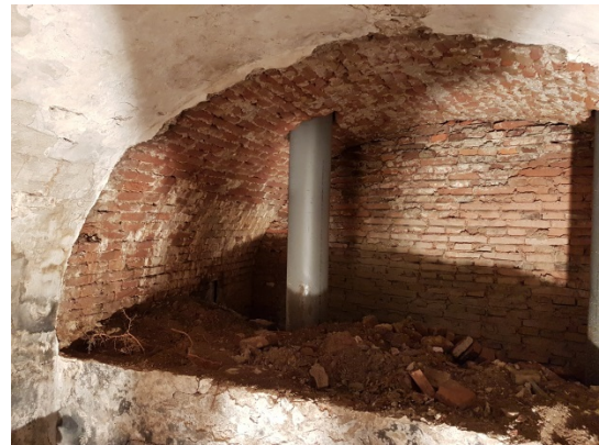
Figuur 51 – in de brugkelder bleek een valse muur te zitten waarvan de functie onbekend was. In overleg met archeologie is de muur gesloopt en is het achterliggende puin verwijderd. In het puin werd diverse aardewerk gevonden, waaronder Romeins Terra Sigilata
