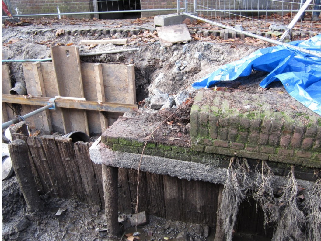
Figuur 38 – de gemetslede walmuur komt vrij te liggen tijdens de renovatie
