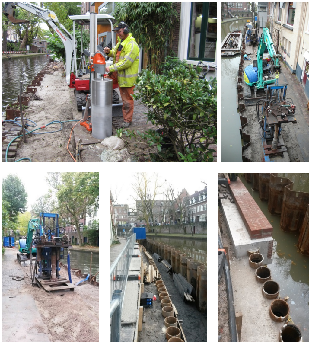
Figuur 12 – foto's uitvoering palenwand 'boomspecial' dicht naast bebouwing op Twijnstraat aan de werf (rak 15). Achtereenvolgens: (1) kernboring door walmuur; (2) kernboring, kraan en palenboormachine (3) kleine boorstelling die palen aanbrengt; (2) palenwand na ontgraving; (3) afgewerkte palenwand met beton en metselwerk naast werk in uitvoering.
