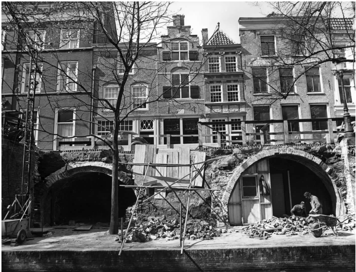
Figuur 19 – foto genomen bij de vervanging van de werfmuur voor adres Nieuwegracht 35–39 anno 1976. Uit de rechterzijde op de foto komt een variant van de opbouw van de werfkelder naar voren. Het gewelf is vanaf maaiveld in een keer doorgetrokken (halfgrondboog?). De vrij massieve en hoge steunmuur is later tegen de boog aan gemetseld. Wat verder ook opvalt is dat de rechter kelder de maximale hoogte heeft benut, en er nog amper sprake is van gronddekking op het gewelf. Op het linker gewelf is een vrij dikke laag aangebracht die niet in verband met het gewelf is gemaakt. De dikte is te groot voor een traditionele afdekking van 1 of 2 lagen plavuizen, maar lijkt een eigen halfsteens boog te zijn waaraan wellicht een extra draagvermogen is te ontlelen.
