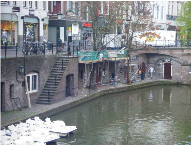
Foto 9 werk in uitvoering, herstel werfmuren nabij de stadhuisbrug
