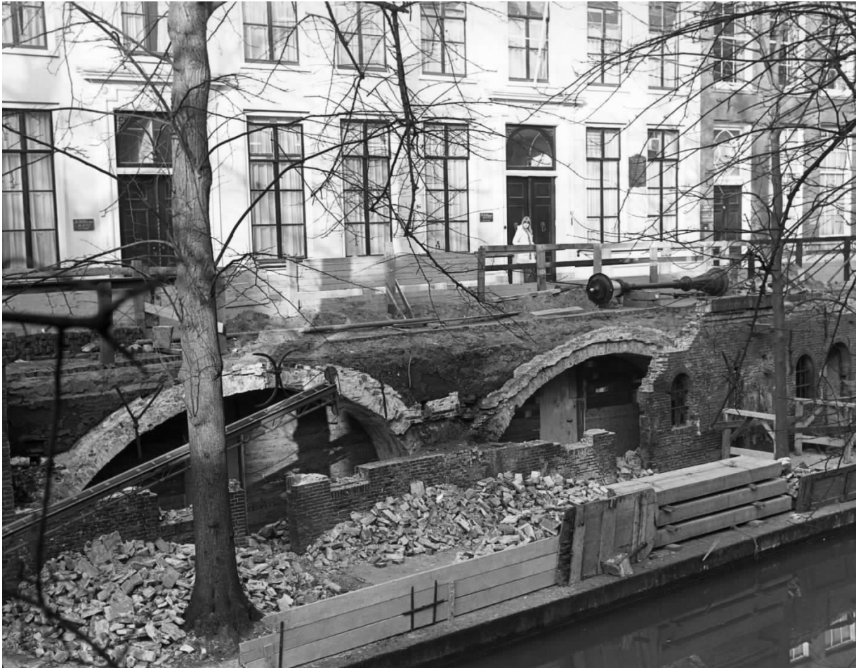
Figuur 20 – Foto genomen tijdens de sloop van de werfmuur bij Nieuwegracht 19 en 21 anno 1976. Bij de sloop van de werfmuur bij de panden Nieuwegracht 19 en 21 komen op de foto van Figuur 20 2 hele grote en brede werfkelders bloot te liggen. De opbouw volgt niet de traditionele vorm van wand met tonboog. De linker kelder oogt alsof deze 1½ steens is uitgevoerd in een verband, wat vrij uitzonderlijk zou zijn. De rechter kelder oogt van een vergelijkbare dikte waarbij er geen verband tussen de onderste en het bovenste lijkt te zijn, en in opbouw vergelijkbaar met de linker kelder op Figuur 19.
